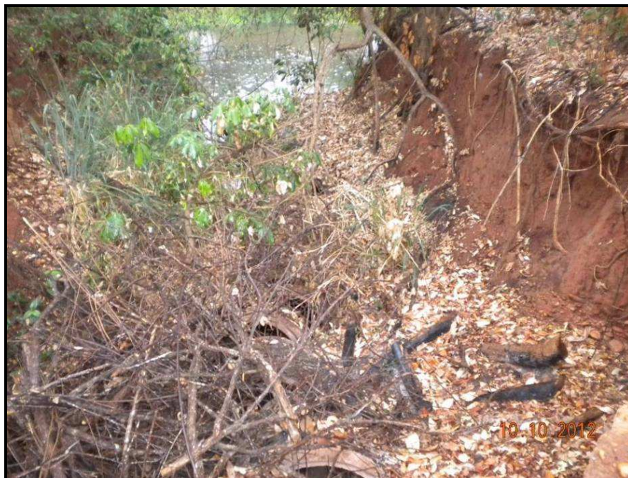
FOTO 3 – MARGEM ESQUERDA DO RIO BONITO – EROSÃO DE MÉDIO PORTE NO DESÁGUE DA REDE PLUVIAL DA VILA DE FURNAS.
