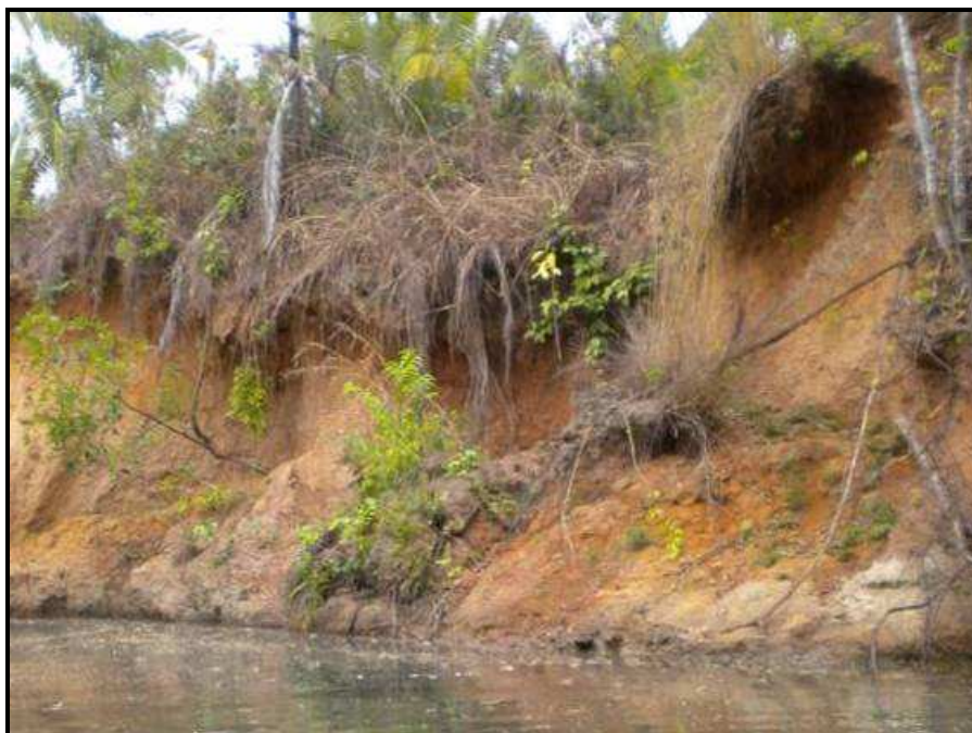
FOTO 16 – DETALHE DO PROCESSO EROSIVO E ESCORREGAMENTOS (PONTO 30).
