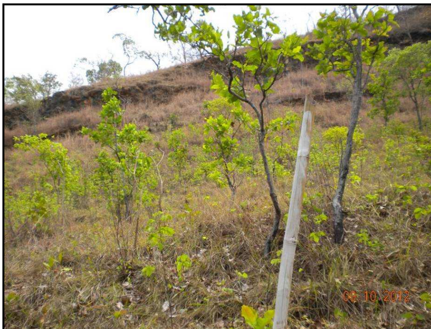
FOTO 23 – DETALHE DA ENCOSTA - DEPÓSITO COLÚVIO/TÁLUS – NOTAR ABATIMENTO AO FUNDO (PONTO 15).
