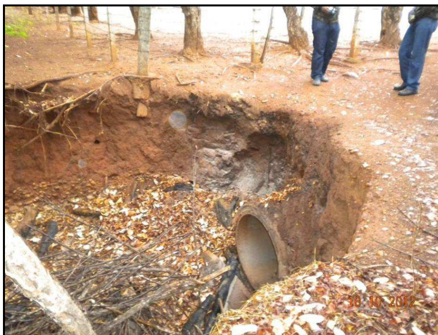
FOTO 4 – MARGEM ESQUERDA DO RIO BONITO – DETALHE DA REDE PLUVIAL DA VILA DE FURNAS.
