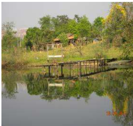
Vistoria de irregularidade trapiche fixo de madeira.
