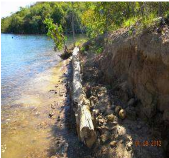
Talude na ilha 75.
