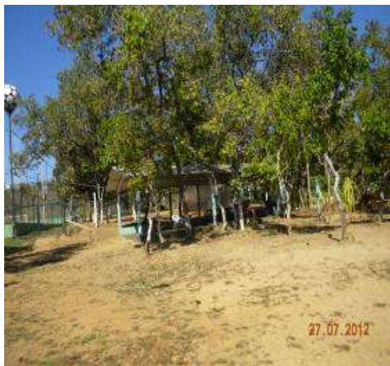
Vistoria complementar construção em APP.
