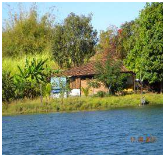
Vistoria complementar construção em APP.
