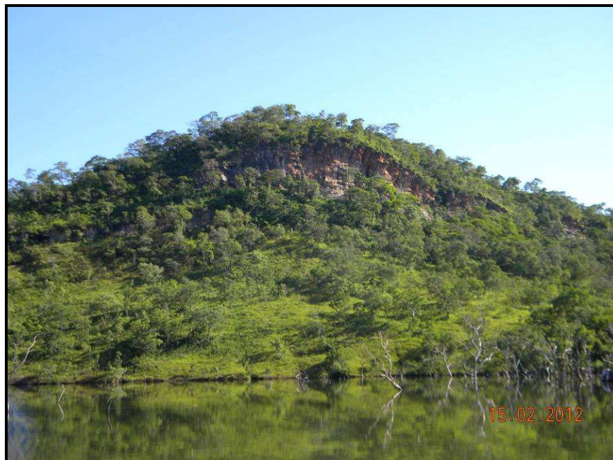
FOTO 26 – PONTO 15 - VISTA PARA MONTANTE DO MATERIAL COLÚVIAL/TÁLUS EM ENCOSTA CÔNCAVA DO TALUDE MARGINAL.
