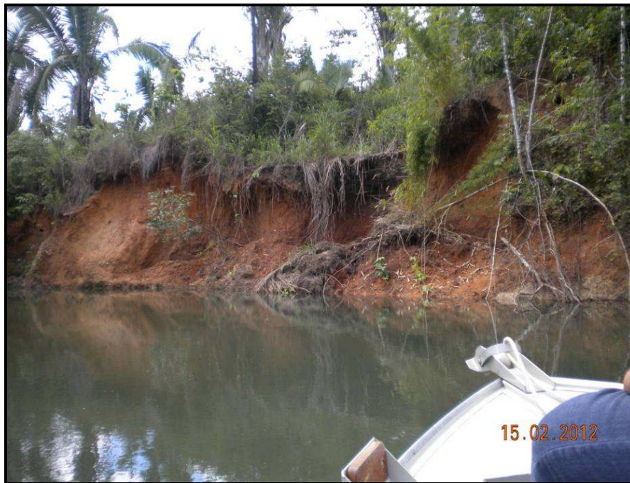
FOTO 15 – VISTA DO PROCESSO EROSIVO NA MARGEM COM FALTA DE RECOMPOSIÇÃO DA MATA CILIAR.
