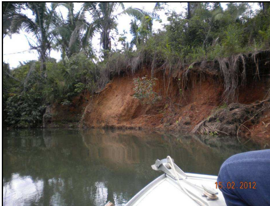
FOTO 16 – DETALHE DO PROCESSO EROSIVO, COM EROSÃO A MARGEM.
