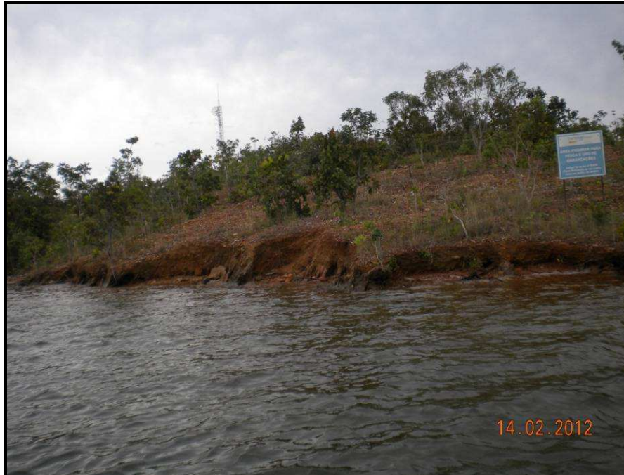
FOTO 29 – PONTO E - EROSÕES LOCALIZADAS EM TALUDES MARGINAIS. EFEITO EROSIVO POR AÇÃO DAS ONDAS, COM ASSOREAMENTO EM PROGRESSO.
