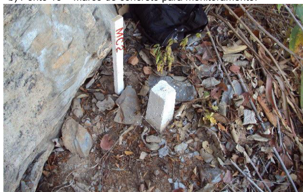
d) Ponto 15 – Marco de concreto para monitoramento.
