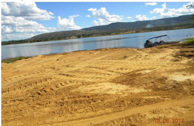
g) Aterro no reservatório (RO-11)
