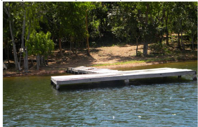
d) Trapiche fixo de madeira no reservatório (RE-04)
