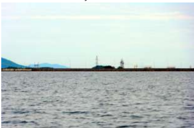
065 – USINA HIDRELÉTRICA CANA BRAVA
