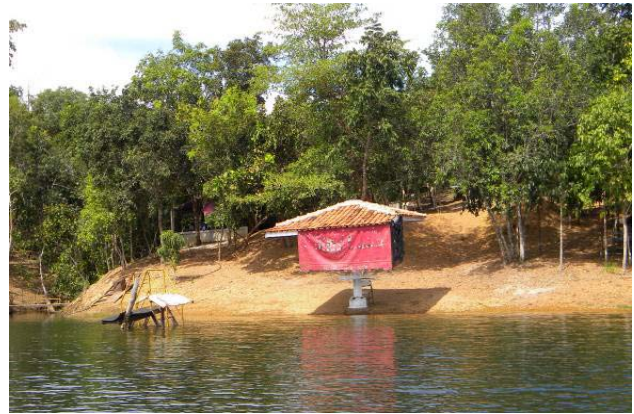
d) Quiosque construído na APP (RE-04)
