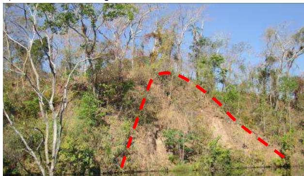
e) Ponto 27 – Escorregamento estabilizado.
