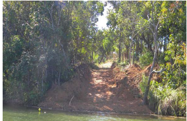
f) Abertura de acesso na APP (RO-11).
