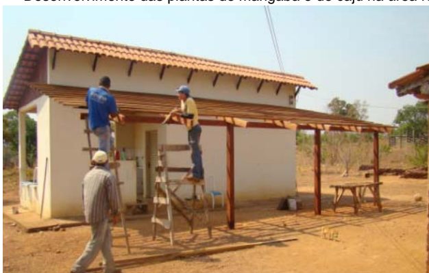
Ampliação da casa no lote 03 do RRCP, em setembro.
