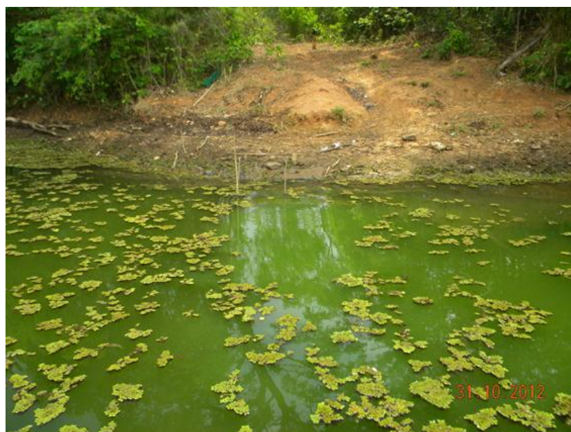
Figura 02: Vista do emissário de efluentes da ETE de Minaçú, lançado grande massa algal.
