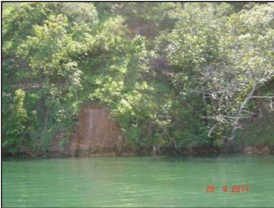
FOTO 22 – PONTO 16 - BARRANCA NA MARGEM DIREITA DO RIO TOCANTINS. EROSÕES POR EMBATE DE ONDAS, MATERIAL SAPROLÍTICO, MUITO FRIÁVEL, COM BAIXA COESÃO EM TALUDE SV. EVOLUÇÃO DO ASSOREAMENTO.
