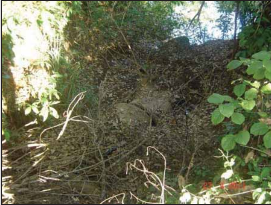
FOTO 6 – MARGEM ESQUERDA DO RIO BONITO - DESÁGÜE DA REDE PLUVIAL DA VILA DE FURNAS.
