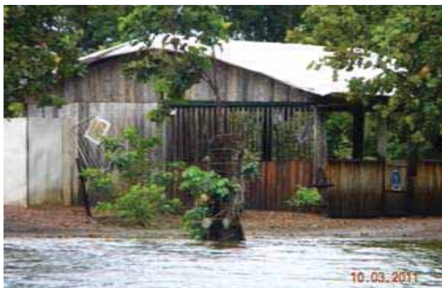
a) Edificação Irregular (RE-04)
