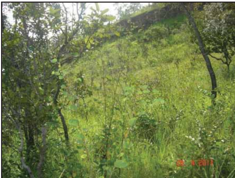
FOTO 26 – DETALHE DA FOTO ANTERIOR, MOSTRANDO O DEPÓSITO DE ENCOSTA (COLÚVIO/TÁLUS) NO TALUDE MARGINAL. VISTA PARA MONTANTE (PONTO 15).
