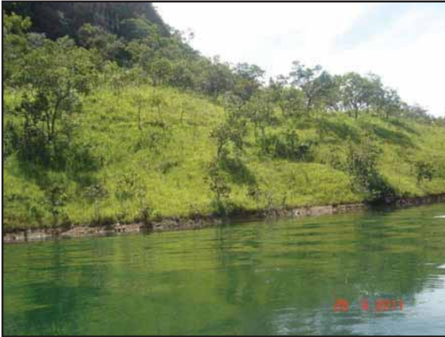
FOTO 31 – ENCOSTA CÔNCAVA SUSTENTADA POR MATERIAL COLÚVIONAR/TÁLUS. PONTO 15.
