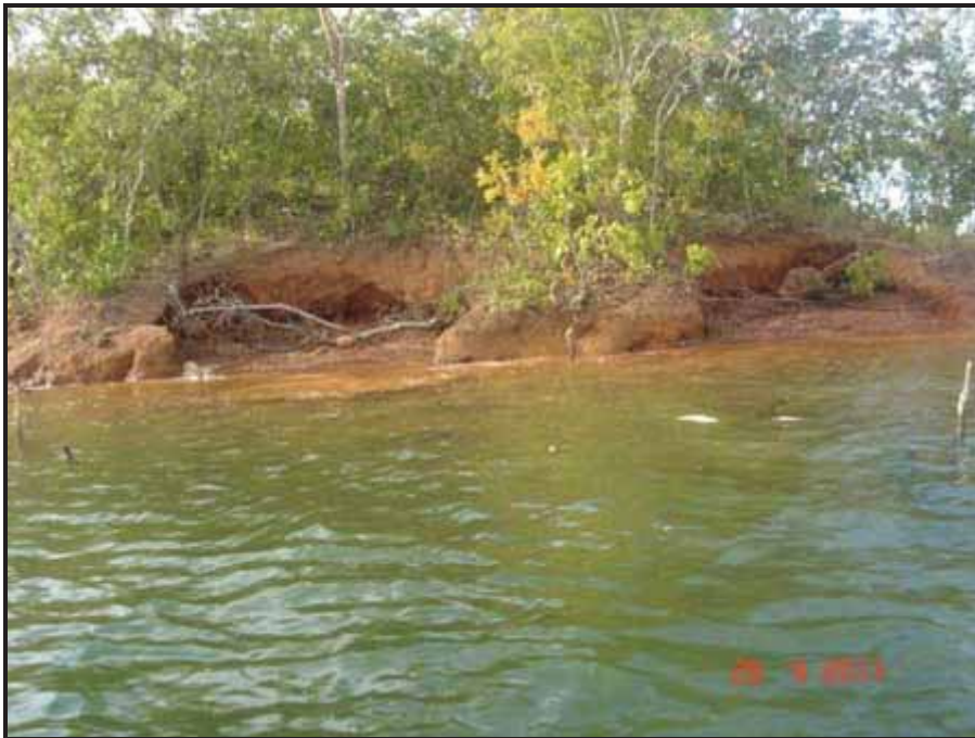
FOTO 36 - EROSÕES POR AÇÃO DE ONDAS NOS TALUDES MARGINAIS BAIXOS, DE DIVERSAS ILHAS NO LAGO DA UHE CANA BRAVA. ASSOREAMENTO EM MARCHA. PONTO D.
