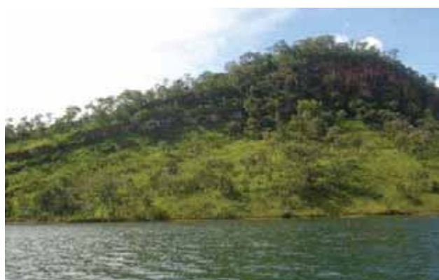
e) Margem direita do Rio Tocantins (Ponto 15) vista para montante da escarpa, com degrau de abatimento e depósito de colúvio/tálus no talude marginal.
