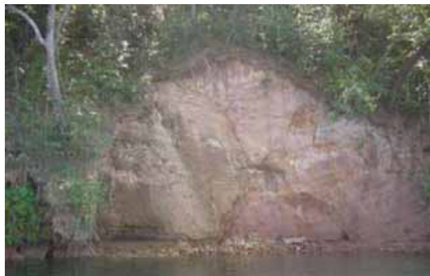
d) Margem direita do Rio Tocantins (Ponto 16) com erosões por embate de ondas, material saprolítico, muito frágil, com baixa coesão em talude sv. e evolução do assoreamento.
