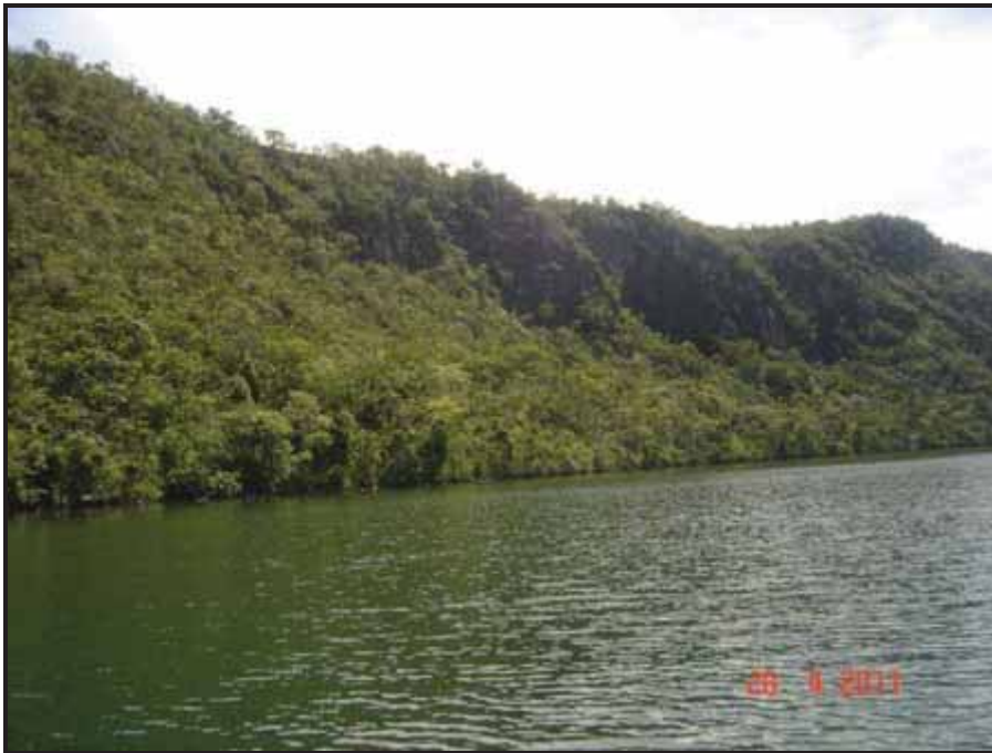
FOTO 11 – MARGEM DIREITA DO RIO TOCANTINS (PONTO 14). ESCARPAS COM QUEDAS LOCALIZADAS DE LASCAS E BLOCOS E CONES DE COLÚVIO/TÁLUS NA MEIA-ENCOSTA E BASE DO TALUDE.
