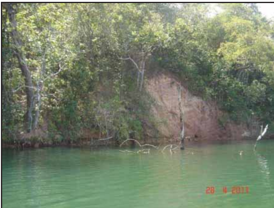
FOTO 23 – PONTO 16 - NOTAR A ESTRUTURA RELIQUIAR DA ROCHA NO MATERIAL SAPROLÍTICO, MUITO ERODÍVEL. ASSOREAMENTO EM PROGRESSO.
