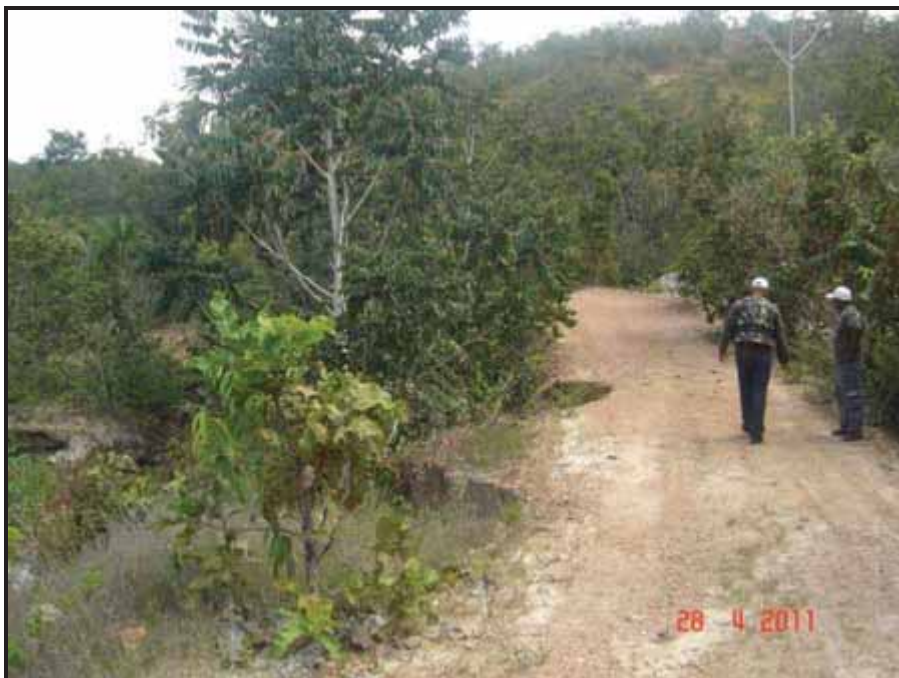
FOTO 20 – VISTA GERAL DA ÁREA DEGRADADA E INTENSAMENTE ERODIDA/INSTABILIZADA JUNTO À ESTRADA, NAS PROXIMIDADES DA FOZ DO RIO DAS PEDRAS, MARGEM ESQUERDA DO RIO TOCANTINS (PONTO 26).
