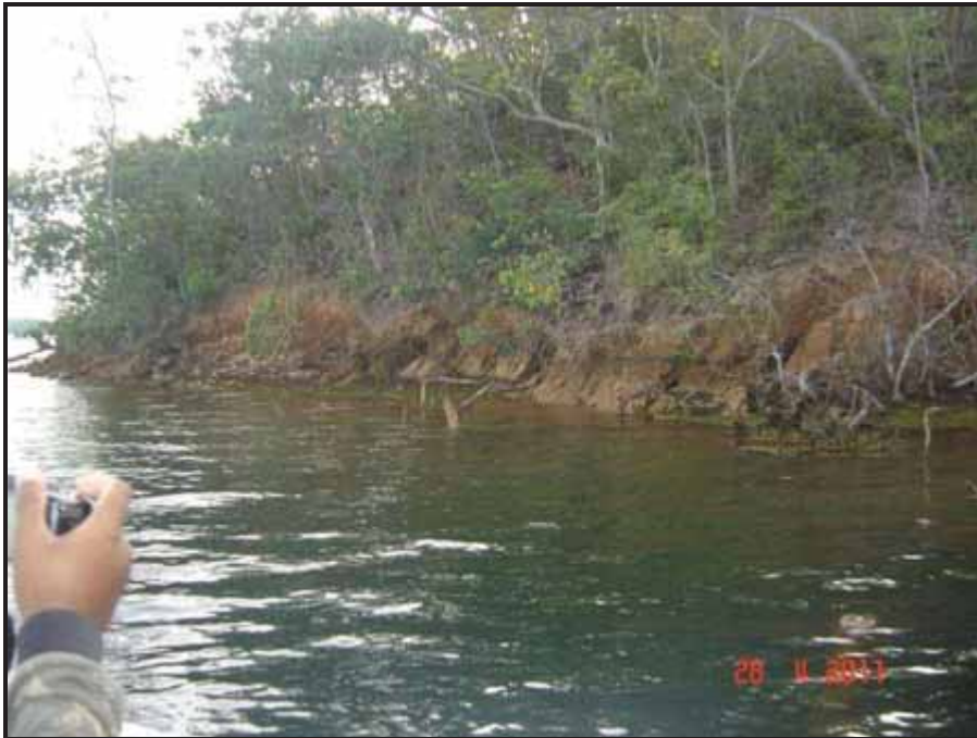
FOTO 2 - MARGEM DIREITA DO RIO BONITO – EROSÕES POR ONDAS (PONTO 5) – PEQUENA EVOLUÇÃO NO PROCESSO EROSIVO/ASSOREAMENTO EM RELAÇÃO A ULTIMA VISTORIA.
