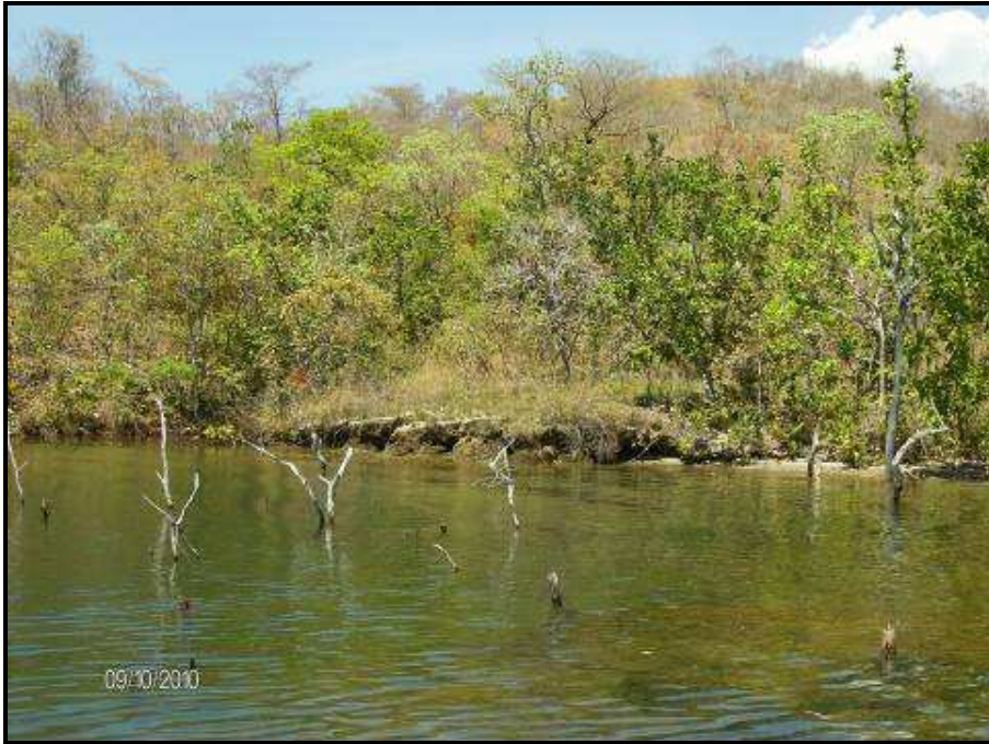
FOTO 35 – EROSÕES / ASSOREAMENTO, POR AÇÃO DE ONDAS EM TALUDES BAIXOS DE DIVERSAS ILHAS NO RESERVATÓRIO DA UHE CANA BRAVA. PONTO C (ILHA 75).
