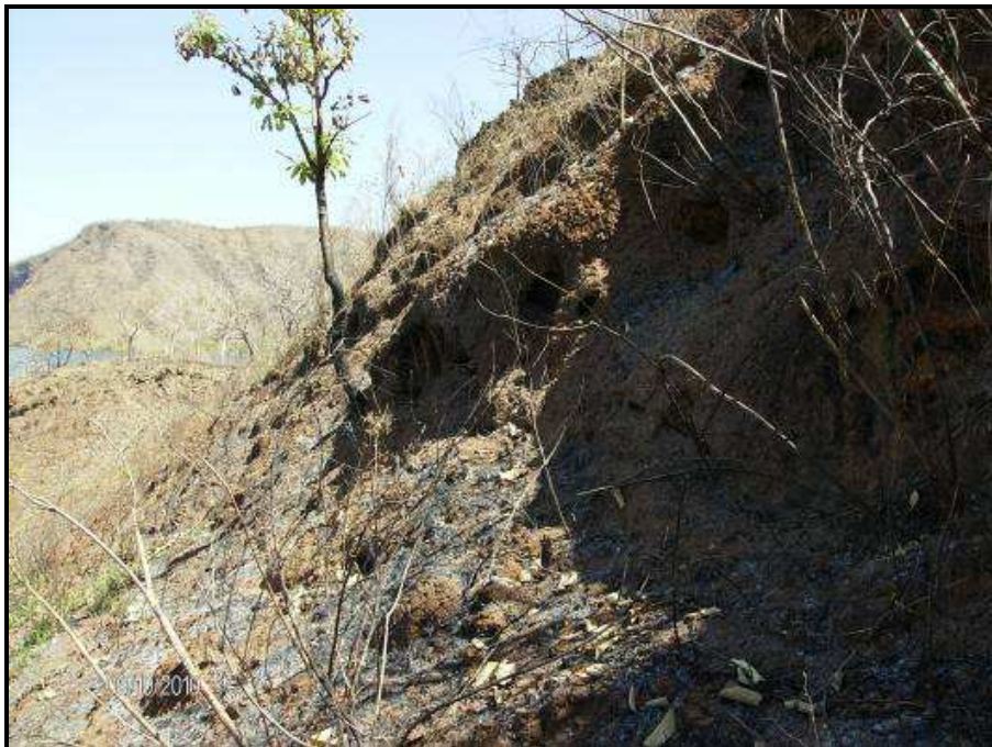
FOTO 27 – DETALHE DO DEPÓSITO DE ENCOSTA (COLÚVIO/TÁLUS) COM DEGRAUS DE ABATIMENTO NAS PARTES SUPERIORES DO TALUDE MARGINAL. VISTA PARA JUSANTE (PONTO 15).
