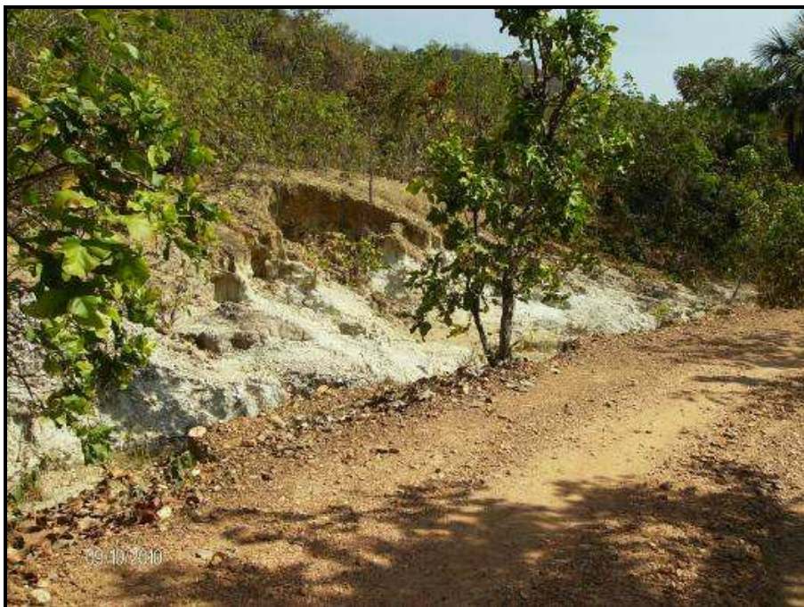
FOTO 21 – ÁREA DEGRADA REFERENTE AO PONTO 26. MARGEM ESQUERDA DO RIO TOCANTINS, PRÓXIMO À FOZ DO RIO DAS PEDRAS.
