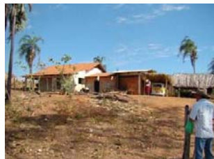
Construção de cozinha externa no RRCABV, lote 05 em agosto.
