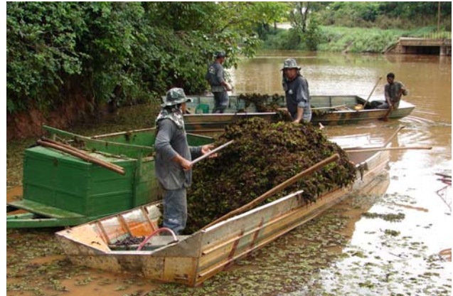
b) Trabalhos de retirada manual das macrófitas.
