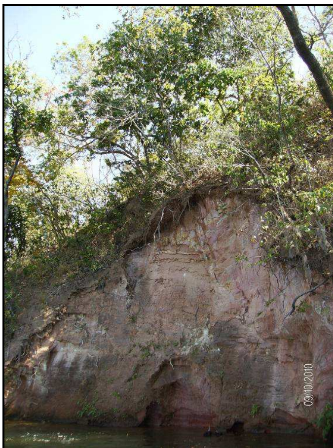
FOTO 24 – PONTO 16 - NOTAR A VERTICALIDADE DO TALUDE (BARRANCA) COM ESCORREGAMENTOS POR SOLAPAMENTO DA BASE DO TALUDE POR AÇÃO DE ONDAS DO RESERVATÓRIO. ASSOREAMENTO PROGRESSIVO.
