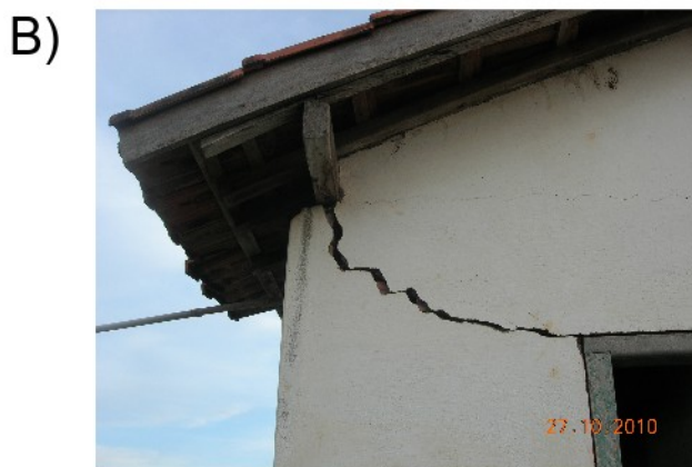
Fotos - A) e B) rachadura e queda de reboco em parede de alvenaria; C) destelhamento.
