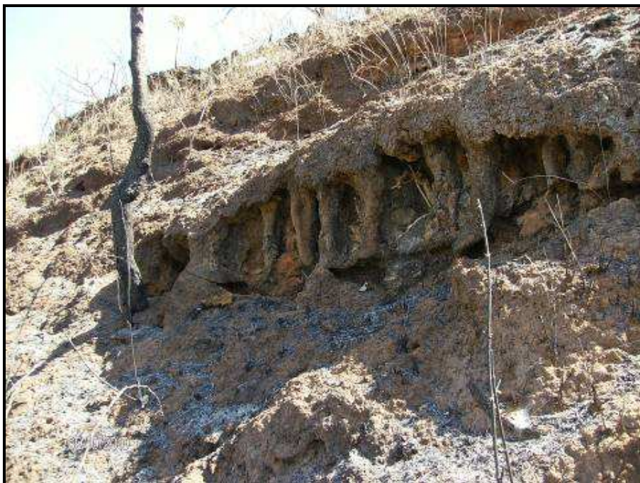
FOTO 30 – DETALHE DOS DEGRAUS DE ABATIMENTO, ESCALONADOS, NAS PARTES SUPERIORES DO TALUDE MARGINAL, CONFORMANDO ENCOSTA CÔNCAVA DO MESMO. PONTO 15.
