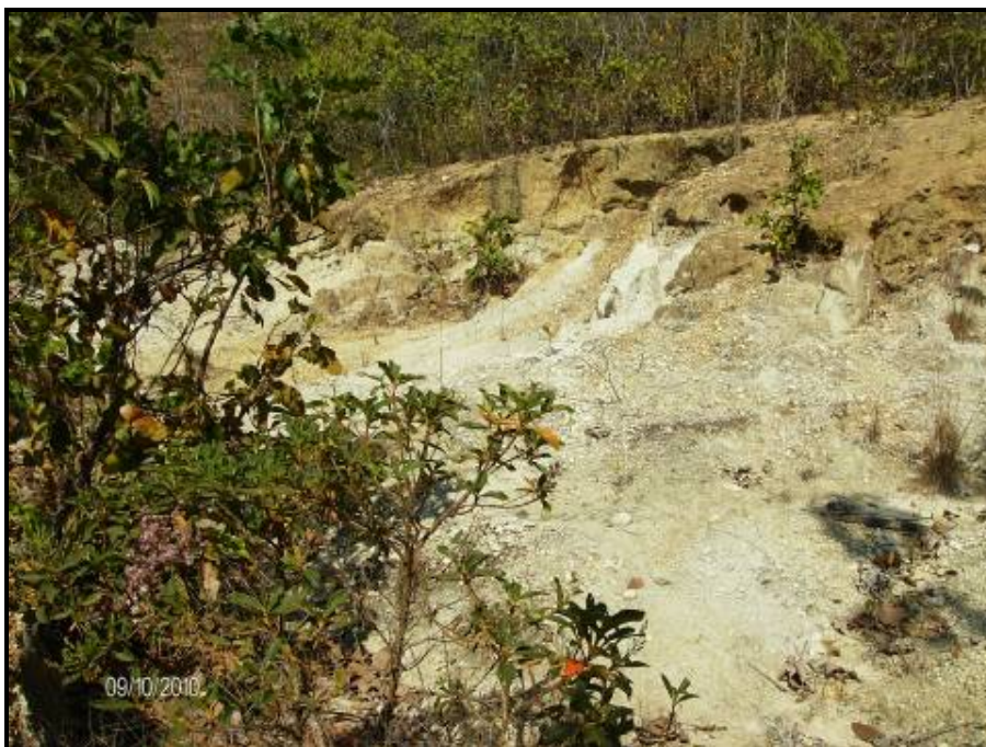
FOTO 15 – MARGEM ESQUERDA DO RIO TOCANTINS, PRÓXIMO À FOZ DO RIO DAS PEDRAS (PONTO 26). ÁREA INTENSAMENTE DEGRADADA, EROSÕES, ASSOREAMENTO ACELERADO.
