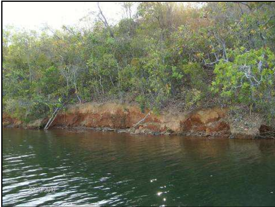
FOTO 2 - MARGEM DIREITA DO RIO BONITO – EROSÕES POR ONDAS (PONTO 5) – PEQUENA EVOLUÇÃO NO PROCESSO EROSIVO/ASSOREAMENTO.
