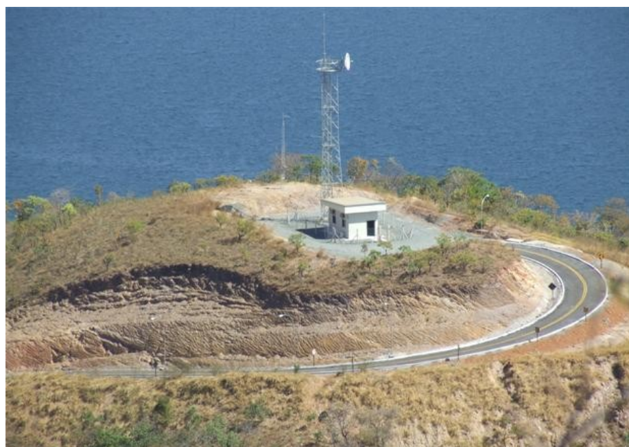
Figura 02 – Vista do Prédio de Telecomunicações da UHE São Salvador, onde são recebidos os sinais
