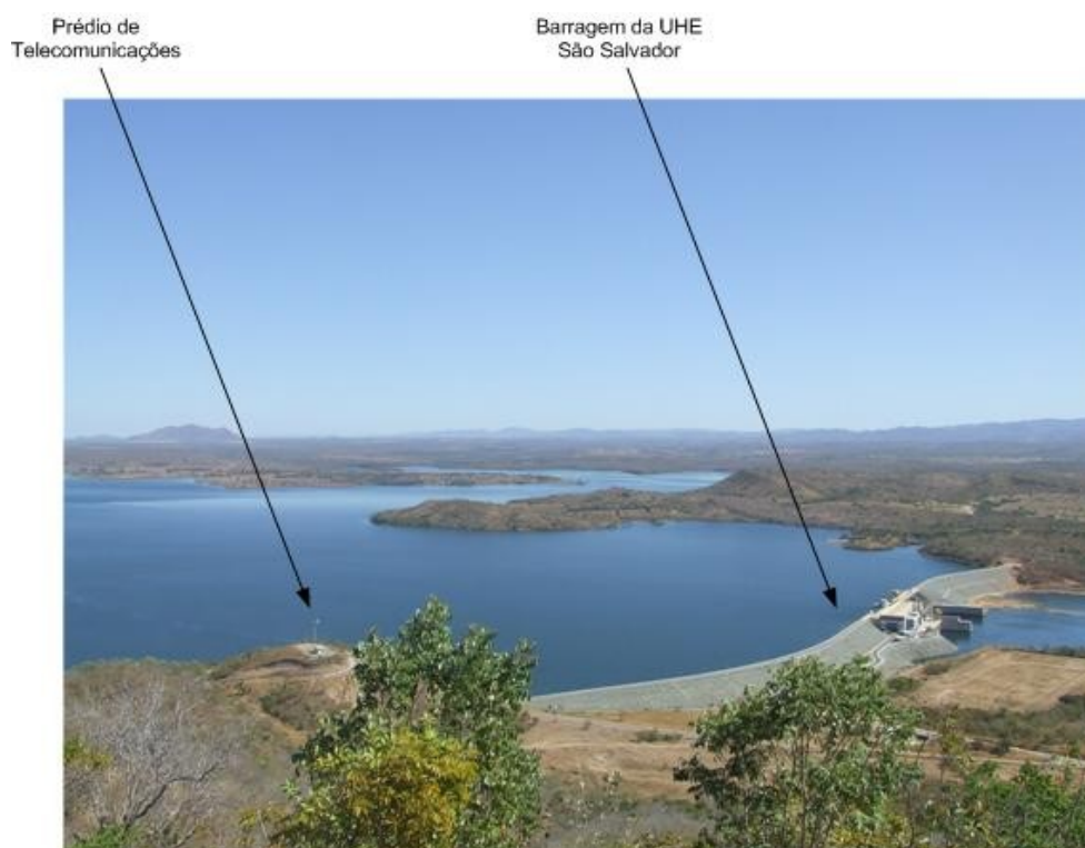
Figura 01 – Vista do Prédio de Telecomunicações - para onde foi relocada a Estação Central de Recepção - e da barragem da UHE São Salvador.
