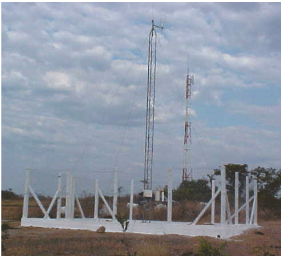
Estação Meteorológica Automática Telemétrica instalada no município de Minaçu, na área do empreendimento UHE – Cana Brava. Data de início de operação: setembro de 2003.
