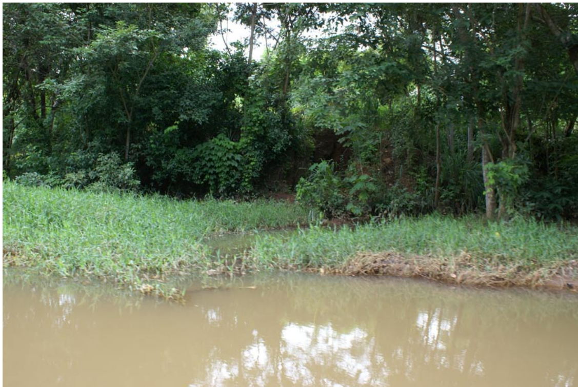
Figura 51: Vista do emissário da ETE de Furnas, em 24 de março de 2009, e o lançamento de água enegrecida ao longo da região marginal do reservatório.
