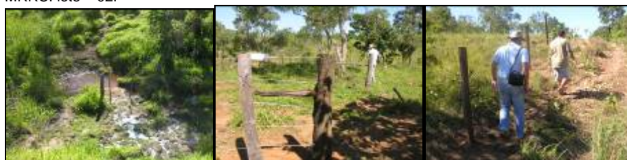
Fotos 01: passagem de animais de difícil acesso lote - 05. Fotos 02 e 03: Cerca construída na área de Reserva Legal lote – 06
