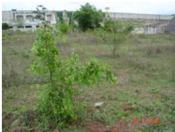
Figura 5. Britador – Área Revegetada e Situação Atual – Antigo Canteiro de Obras
