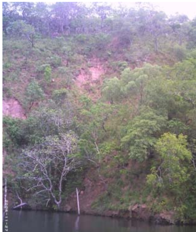
Foto 2: Área D1 em processo de estabilização.
