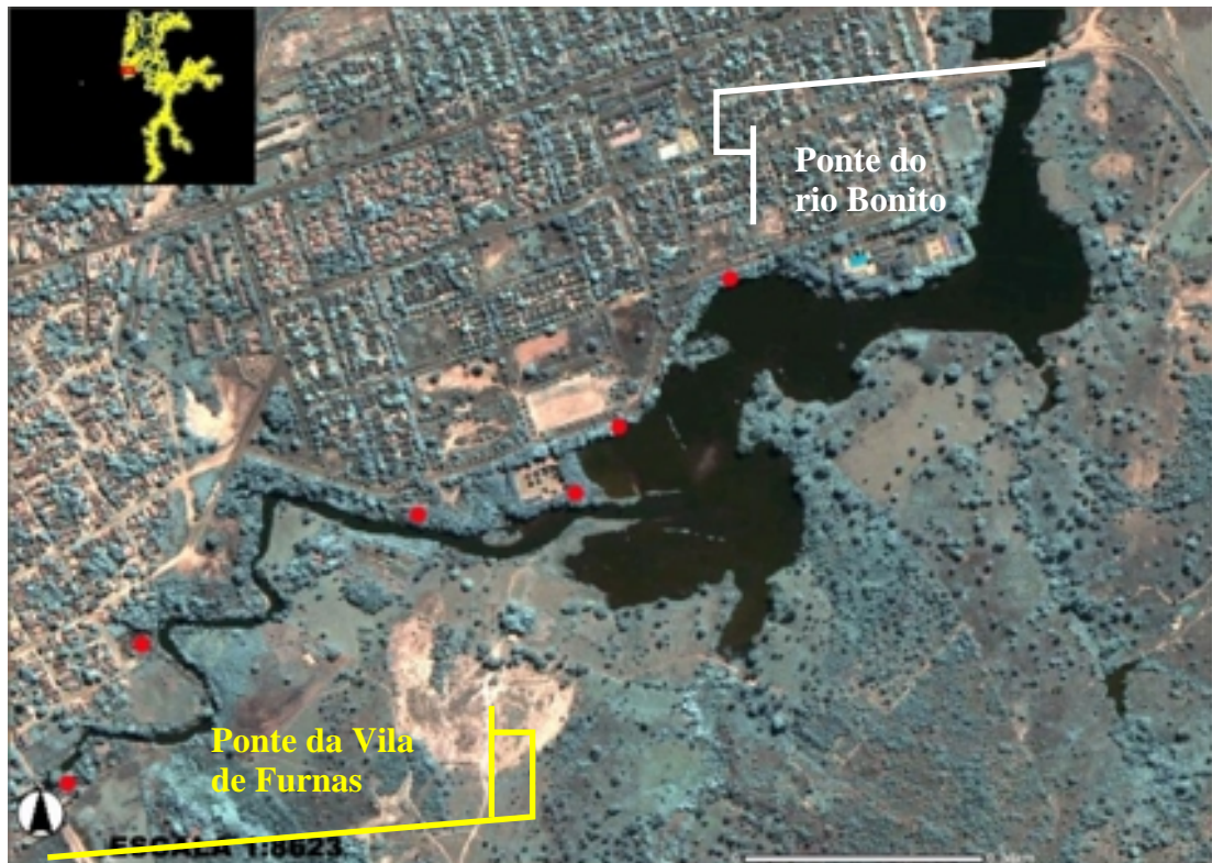
Figura 1: Trecho vistoriado. Notar locais de ocorrência de processos erosivos e lançamento de águas pluviais. 1
