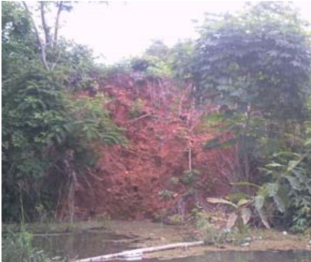
Fotos 10 e 11: Taludes instáveis (rio Bonito e proximidades dos taludes T2 e T3).
