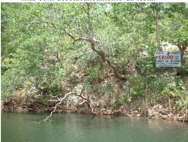
Foto 15: Talude T4, recuperado por vegetação, mas com desbarrancamento da testa.
