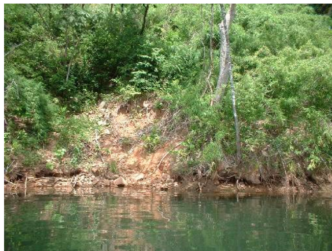
Foto 14: Talude T1 em processo de recuperação pela vegetação.
