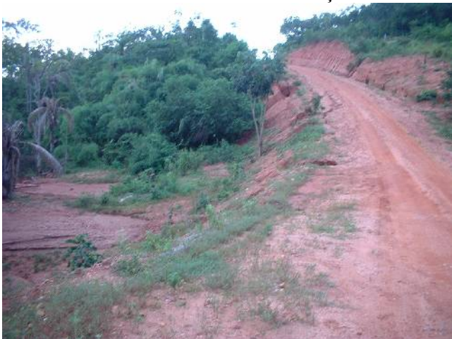
Foto 3: Aterro da Rodovia GO-239, próximo à ponte, em processo acentuado de erosão.
