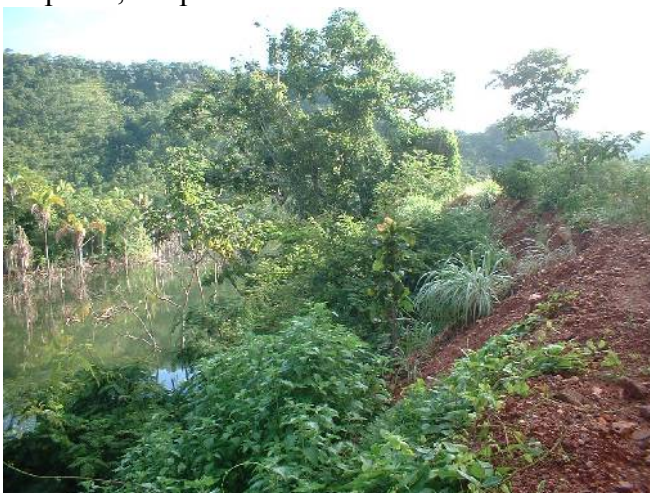
Foto 3: Aterro da Rodovia GO-239, próximo à ponte, em processo acentuado de erosão.
