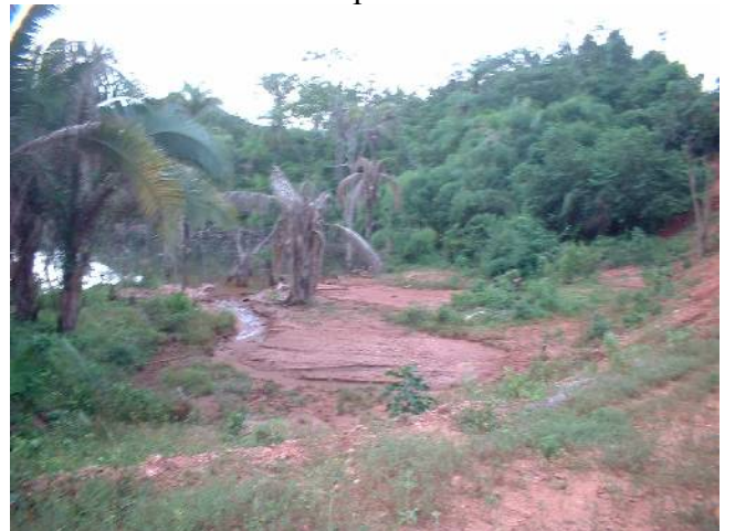
Foto 4: Material erodido do aterro (Foto 3), provocando siltagem do reservatório.
