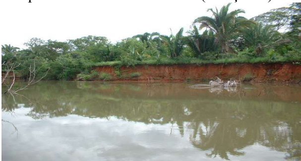
Foto 19: Erosão no aterro de encontro LD da ponte da Rodovia GO-239 (Março/05).
