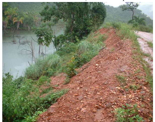
Foto 10: Escorregamento T5 em Março/2005. Talude verticalizado, sem evolução.
