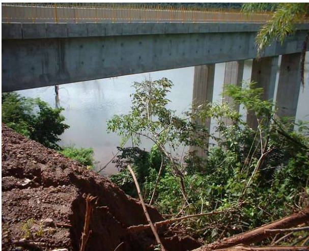
Foto 19: Erosão no aterro de encontro LD da ponte da Rodovia GO-239 (Março/05).
