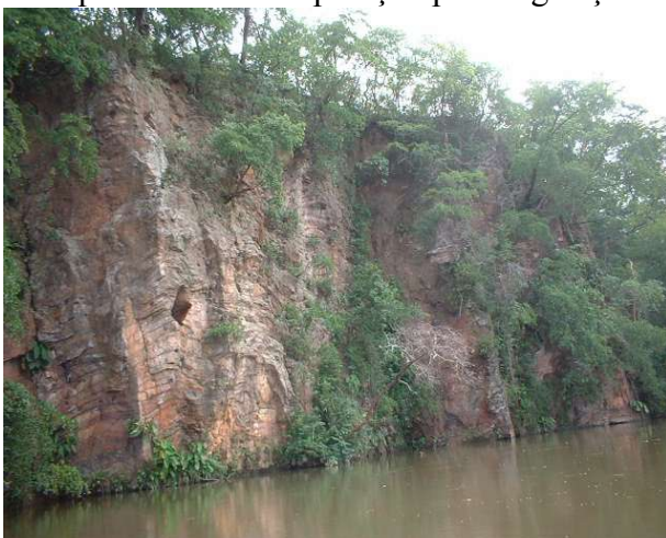
Foto 23: Paredão instável T8, MD Rio São Félix em processo de recuperação pela vegetação.
