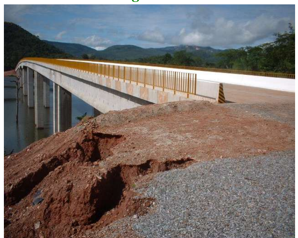
Foto 20: Erosão no aterro de encontro LE da ponte da Rodovia GO-239 (Março/05).
