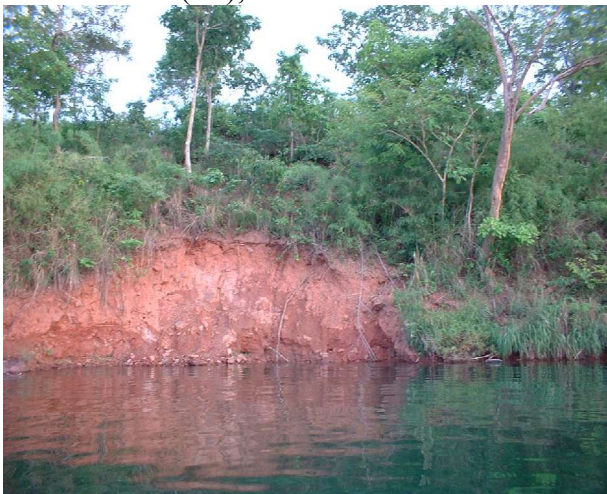
Foto 7: Escorregamento em talude de pequena altura (T3), em Novembro/2004.
