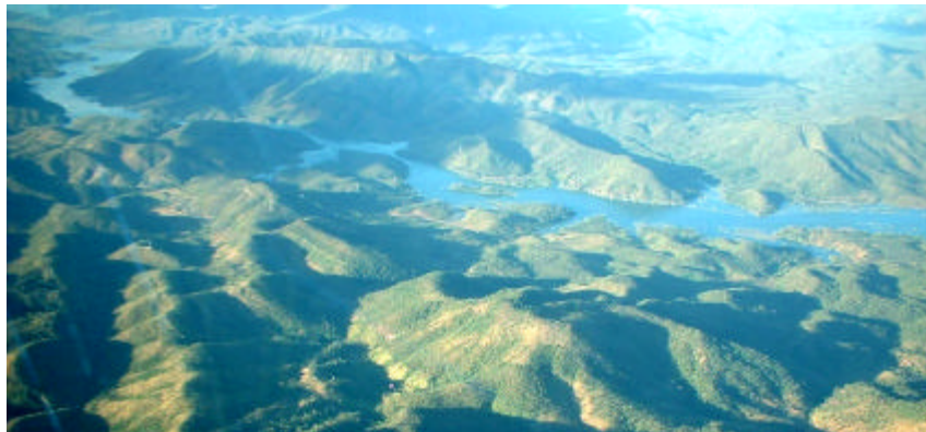
Foto 2: Vista do reservatório entre a foz do rio Preto e a balsa do Rubão. Notar estabilidade dos taludes.
