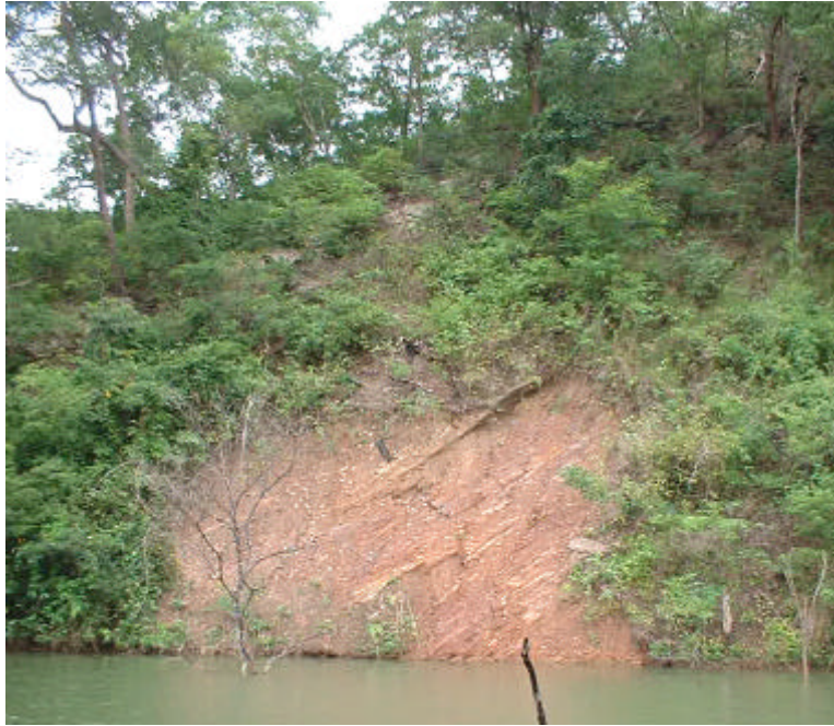
Foto 10: Pequeno talude natural instável, próximo a ES-1.
