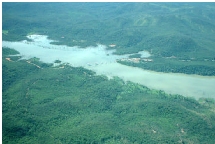
Foto 3: Vista da ponte em construção - rodovia GO-239.
