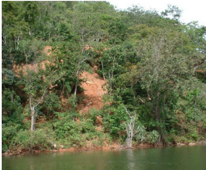
Foto 7: Talude de estrada com erosão - Ribeirão do Carmo.
