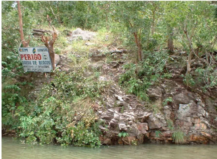
Foto 12: Placa de advertência no local QB-1.
