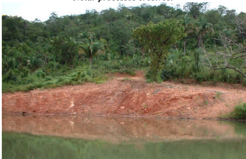
Foto 6: Talude de estrada com erosão - Córrego do Gim.
