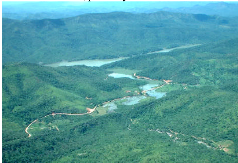
Foto 5: Vista da estrada e ponte sobre o Córrego do Gim. Notar processos erosivos.
