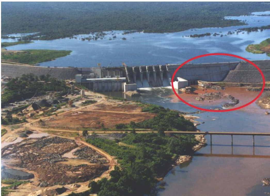
Figura 2. Vista aérea da barragem após o fechamento total dos túneis e a área de resgate.
