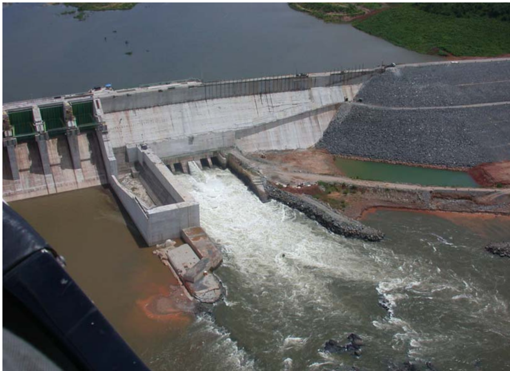
Figura 1. Vista aérea dos túneis de desvio após seu fechamento parcial.
