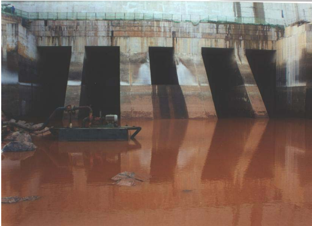
Figura 3. Bombeamento da enseadeira de jusante.
