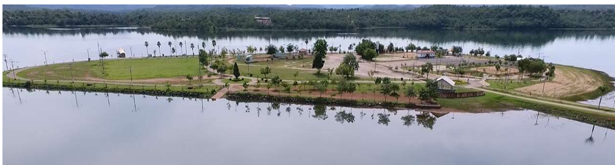
Figura 5-XVI: Praia do Sol em vistoria realizada em dezembro de 2016
