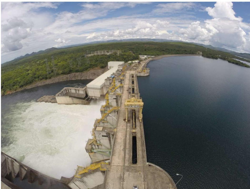
Figura 1-II: Barragem e vertedores da UHE Cana Brava
