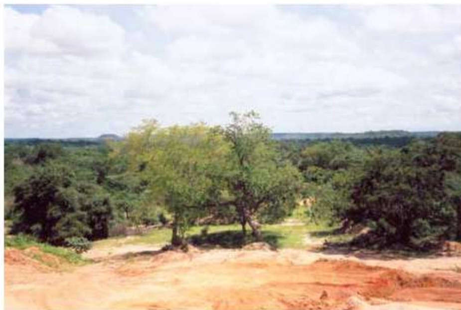
Foto 5.2.3-1 Morfologia da área nas cercanias da barragem de Cachoeira. Observam-se extensos vales interplanálticos pedimentados devido à intensa dissecação. Ao fundo, pequenas mesetas como morro testemunho. Local onde será construído o eixo da barragem de Cachoeira.
