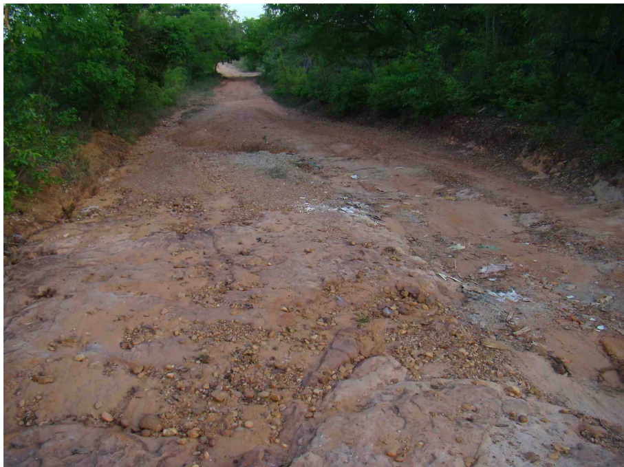
Foto 5.2.3-8 Ocorrência de sulcos e ravinas ao longo das estradas não pavimentadas sobre leito composto por arenitos (ponto CAC-03). Novembro de 2009.
