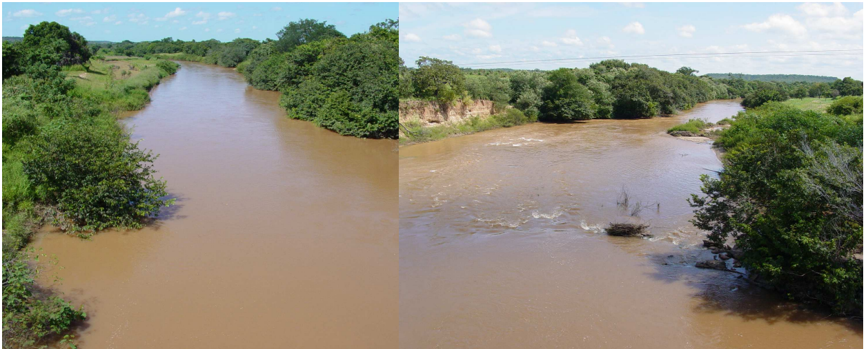
Foto 9.3.1-3 Vista do rio Gurguéia, a montante (acima) e jusante (abaixo) da ponte da rodovia estadual PI 218, no local da estação CC-03.
