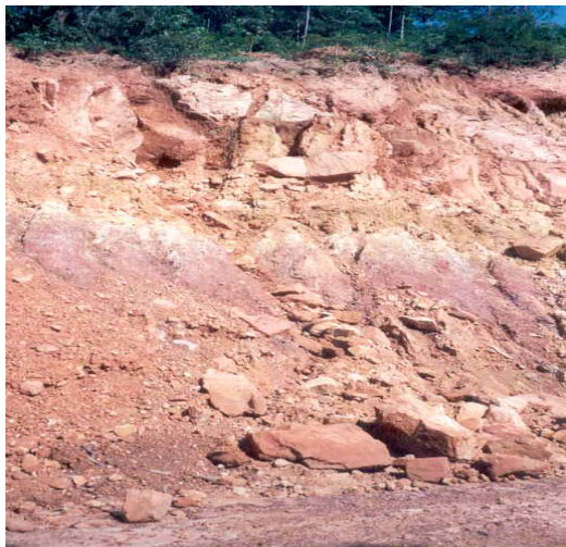
Figuras 5.5-1 Mecanismo 1 - Queda de blocos por erosão diferencial no talude em função da litologia. No esquema à direita arenitos representados em bege e folhelhos em marrom.
