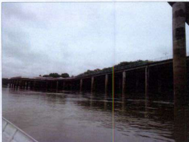
Foto nº 34 - Estrutura para o Lazer em Boa Vista.
