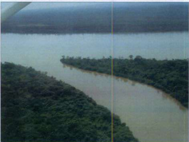
Foto nº 11– Local previsto para instalação da barragem no canal do rio Branco.
