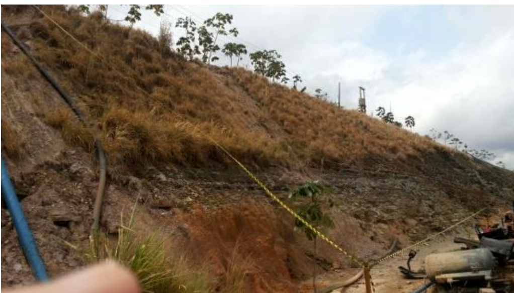
Figura 9.3 - 37 – Polígono previamente demarcado com fita zebraada, na oficina de máquinas pesadas.
