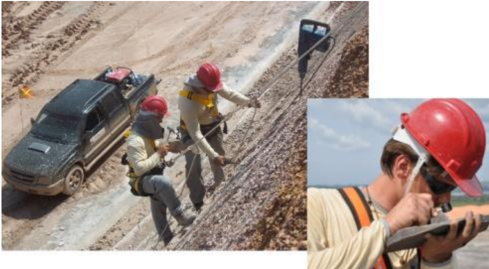
Figura 9.3 - 5 – Procedimento de coleta e análise in situ de fósseis nos canteiros de obra da UHE Belo Monte.
