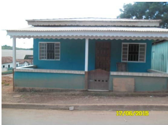
Figura - 1 – Domicílio com evidência de morador – Belo Monte – 6ª Campanha.
