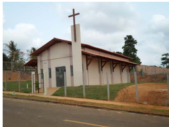
Figura - 4 – Igreja Católica São João Batista reconstruída no RUC Casa Nova
