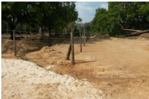
Figura 4.5.3 - 8 – Registro fotográfico do isolamento e limpeza do terreno do estaleiro.
