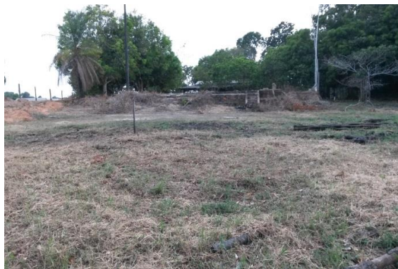
Figura 4.5.3 – 9 - Registro fotográfico do isolamento e limpeza do terreno do estaleiro.
