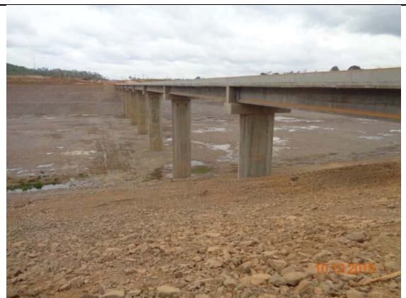
Figura 6 - Vista geral da ponte sobre o canal.
