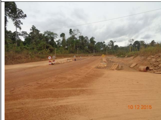
Figura 3 - Encabeçamento na margem direita do canal
