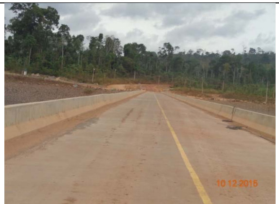
Figura 4 - Vista geral da ponte sobre o canal.
