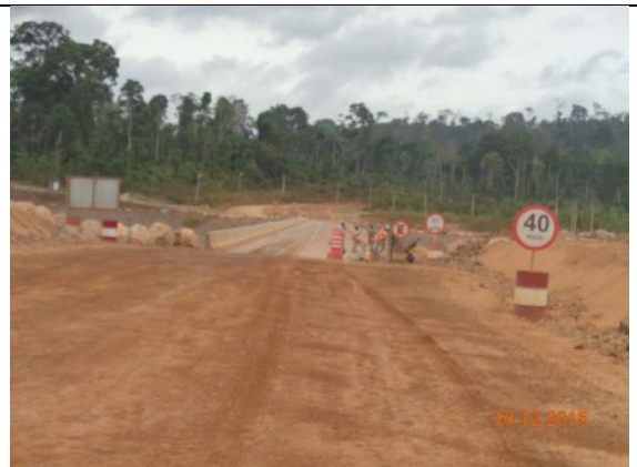
Figura 2 - Vista geral da ponte sobre o canal.
