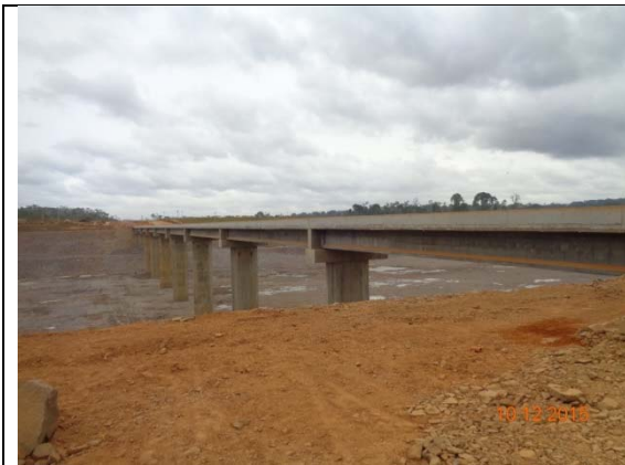
Figura 1 - Vista lateral da ponte sobre o canal.
