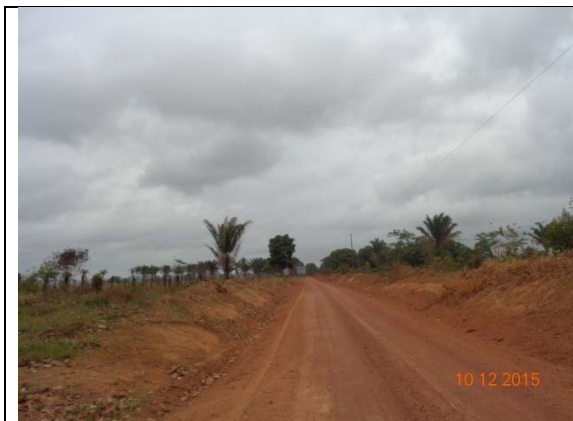
Figura 19 - Trecho da pista do Travessão do Km 18 com serviços de motoniveladoras.
