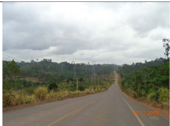
Figura 2 - Trecho pavimentado em bom estado de conservação no Travessão Km 27.
