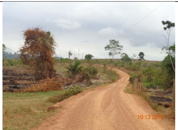
Figura 18 - Trecho do Travessão do Km 18 em bom estado de conservação.
