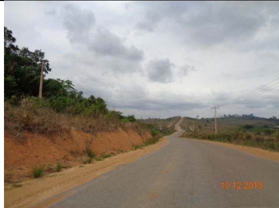
Figura 13 - Trecho da pista do Travessão Km 55 pavimentado em bom estado de conservação.
