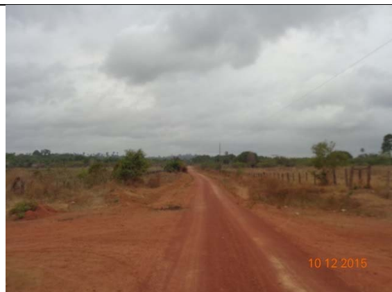
Figura 20 - Trecho da pista do Travessão do Km 18 com serviços de motoniveladoras.
