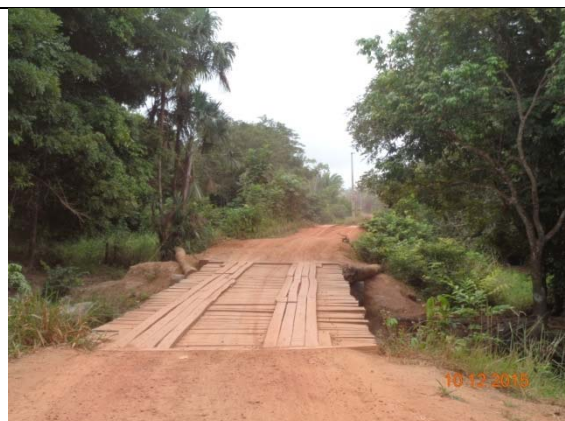
Figura 22 - Ponte sobre o igarapé no Travessão do Km 18
