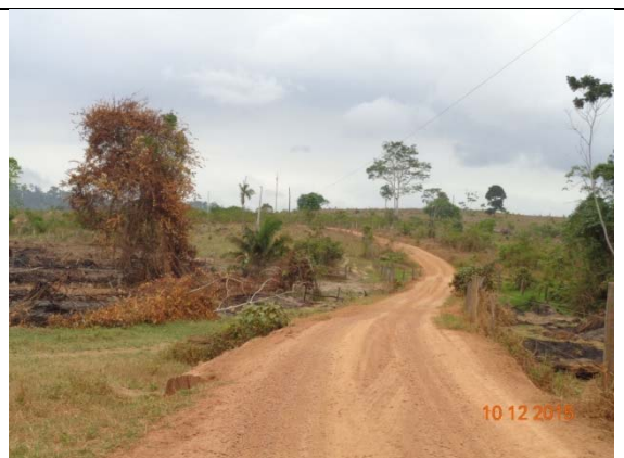
Figura 16 - Trecho do travessão em bom estado de conservação.
