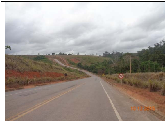
Figura 1 - Trecho pavimentado em bom estado de conservação com sinalização no Travessão Km 27.
