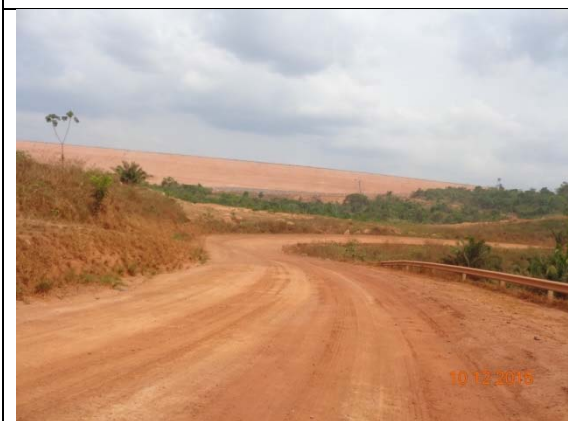
Figura 5 - Trecho em bom estado de conservação no Travessão Km 50.
