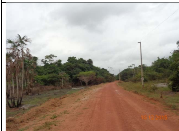
Figura 21 - Trecho da pista com serviços de motoniveladoras no Travessão do Km 18.
