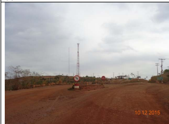
Figura 11 - Trecho não pavimentado do Travessão Km 55 em bom estado de conservação próximo ao Sítio Bela Vista.
