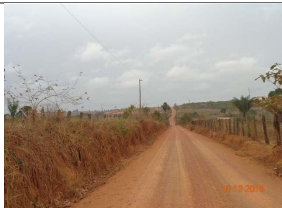
Figura 24 - Trecho da pista no Travessão do Km 23 em bom estado de conservação.
