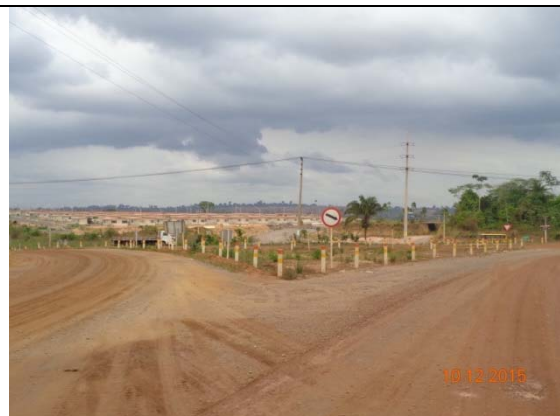
Figura 10 - Trecho da pista no Travessão Km 55 no cruzamento com a BR 230.
