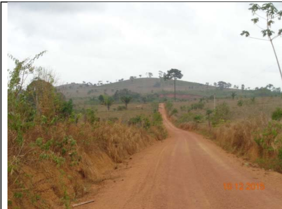
Figura 25 - Trecho da pista no Travessão do Km 23 em bom estado de conservação.
