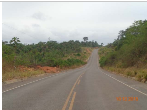
Figura 12 - Trecho da pista pavimentado em bom estado de conservação.
