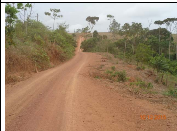
Figura 27 - Trecho da pista no Travessão do Km 23 em bom estado de conservação.
