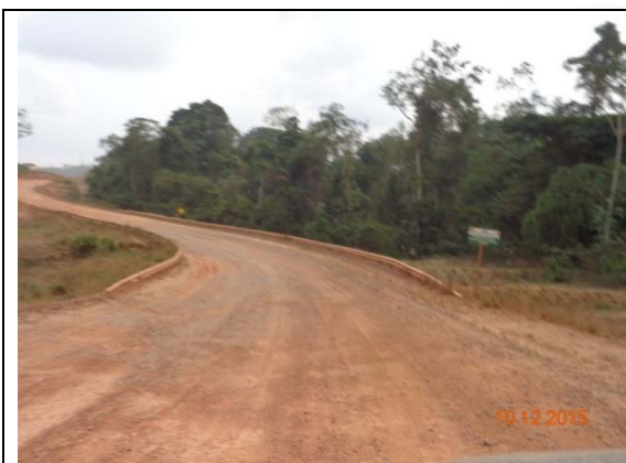
Figura 7 - Trecho em bom estado de conservação do Travessão Km 50.
