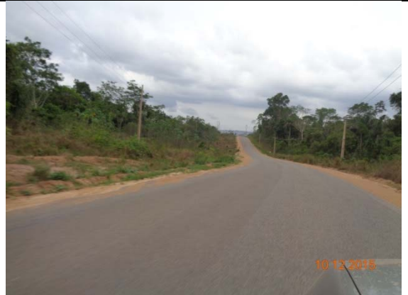
Figura 14 - Trecho da pista Travessão Km 55 pavimentado em bom estado de conservação.
