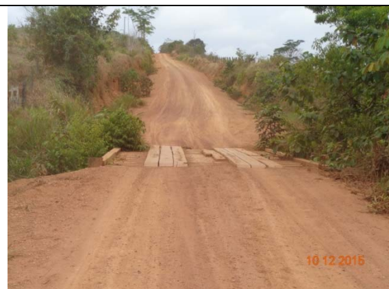
Figura 28 - Trecho da pista no Travessão do Km 23 em bom estado de conservação.
