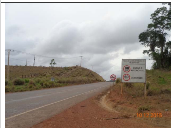
Figura 3 - Trecho pavimentado com placas de sinalização no Travessão Km 27.
