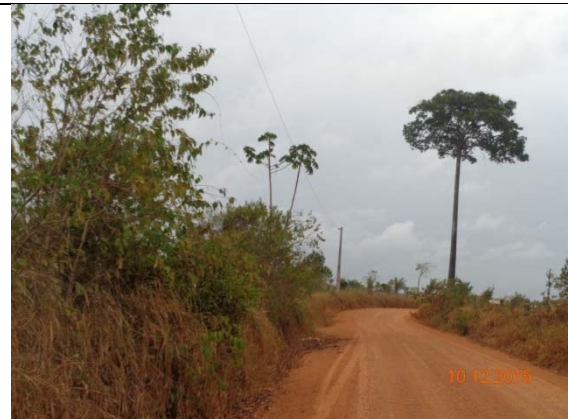
Figura 26 - Trecho da pista no Travessão do Km 23 em bom estado de conservação.
