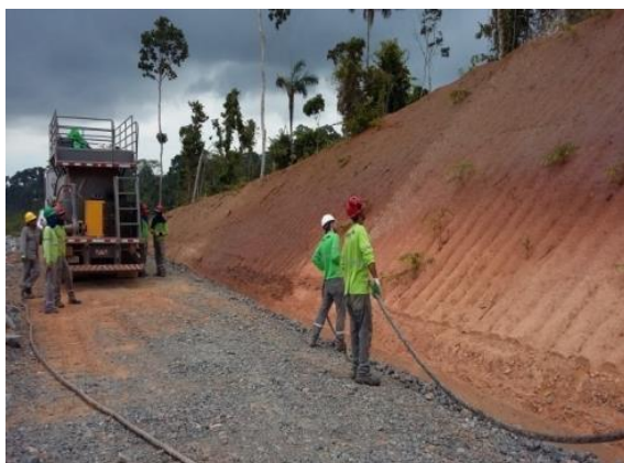
Figura 3.2-27 – Aplicação hidrossemeadura CTCA – Unidade Belo Monte
