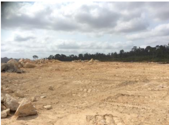
Figura 3.2 - 11 – Conformação do terreno BF-27 – Unidade Canais e Diques
