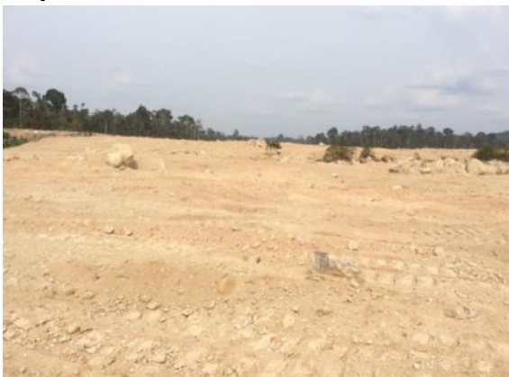
Figura 3.2 - 13 – Conformação do terreno BF-28 – Unidade Canais e Diques
