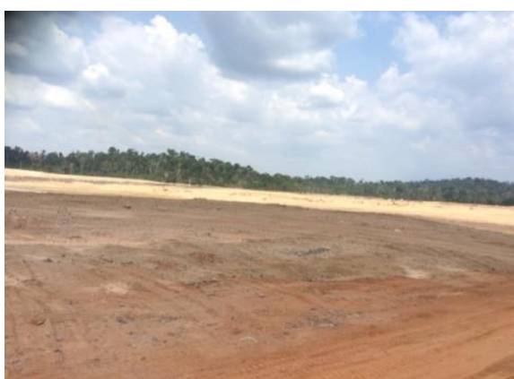
Figura 3.2 -7 – Conformação do terreno – BF-11 Unidade Canais e Diques
