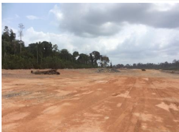
Figura 3.2 - 23 – Lançamento de refúgios de fauna BF-27 – Unidade Canais e Diques
