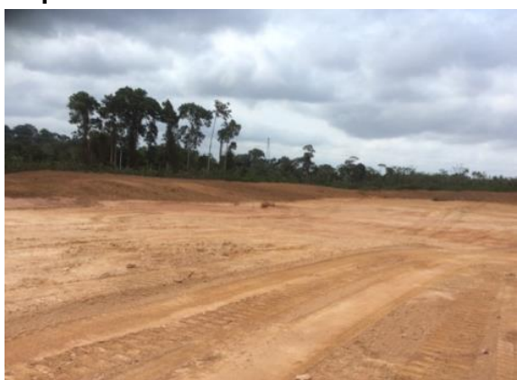
Figura 3.2 - 17 – Conformação do terreno AE-3A – Unidade Pimental
