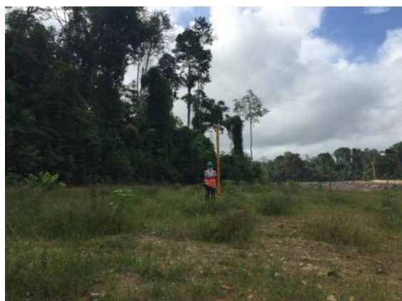
Figura 3.2 - 38 – Monitoramento BF-29 – Unidade Canais e Diques
