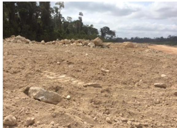
Figura 3.2 - 12 – Conformação do terreno BF-27 – Unidade Canais e Diques
