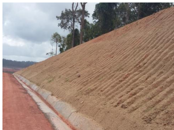
Figura 3.2-28– Talude hidrossemeado CTSA – Unidade Belo Monte
