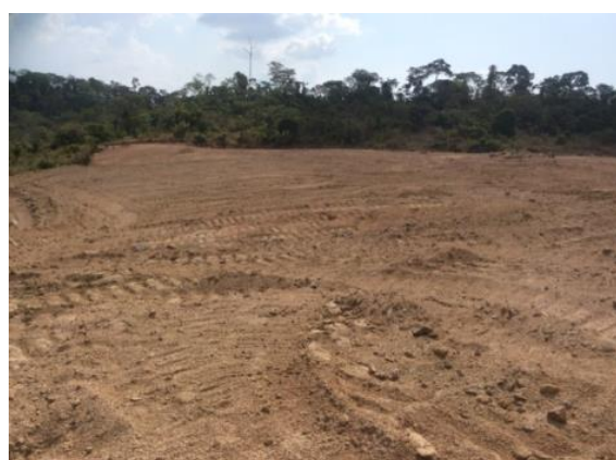
Figura 3.2 - 8 – Conformação do terreno – BF-11 – Unidade Canais e Diques
