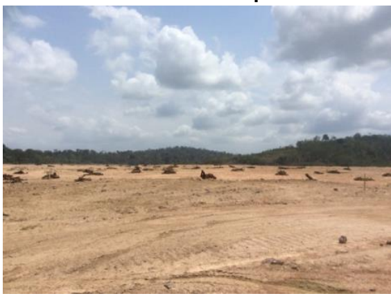
Figura 3.2 - 22 – Lançamento de refúgios de fauna BF-11 – Unidade Canais e Diques
