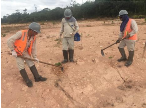
Figura 3.2 - 33 – Realização da atividade de adubação do plantio arbóreo BF-32 –Canais e Diques
