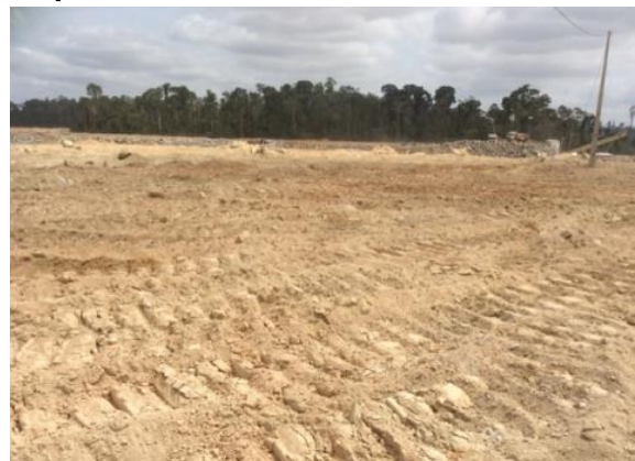
Figura 3.2 - 14 – Conformação do terreno BF-28 – Unidade Canais e Diques
