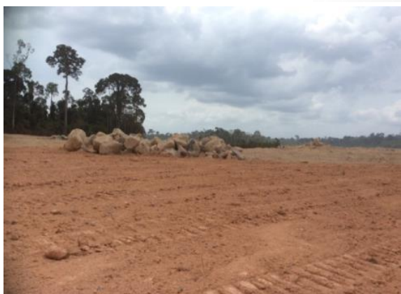
Figura 3.2 - 15 – Conformação do terreno BF-29 – Unidade Canais e Diques
