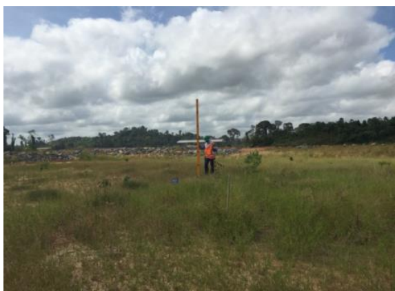
Figura 3.2 - 37 – Monitoramento BF-27 – Unidade Canais e Diques
