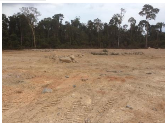
Figura 3.2 - 16 – Conformação do terreno BF-29 – Unidade Canais e Diques
