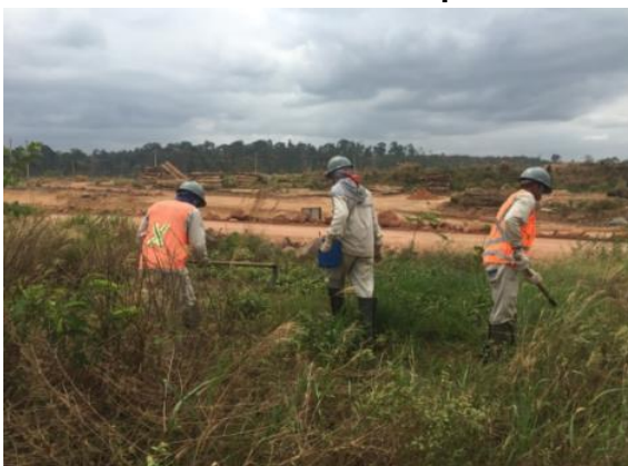
Figura 3.2 - 35 – Realização das atividades de coroamento e adubação do plantio arbóreo BF-36B – Unidade Canais e Diques
