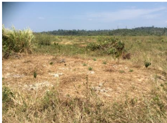
Figura 3.2 - 30 – Atividade de manutenção de capinados núcleos no BF-41– Unidade Canais e Diques
