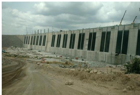
**Figura 3.1 - 2 – Desmobilização de estruturas na Tomada D'água – Sítio Belo Monte**
