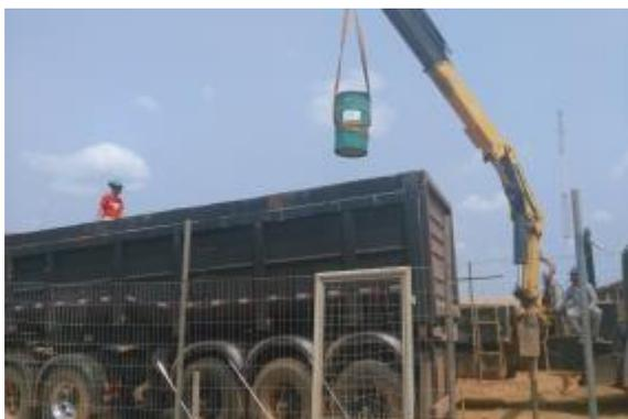
**Figura 3.1 - 58 – Retirada de resíduo contaminado por produto químico para destinação final.**
