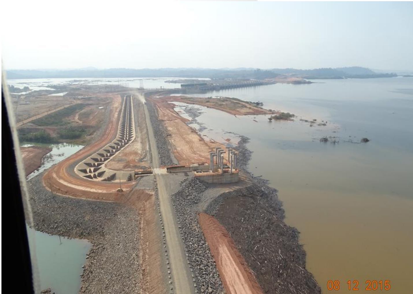
Figura 13.3.6 - 2 – Vista Geral do Sistema de Transposição de Peixes.
