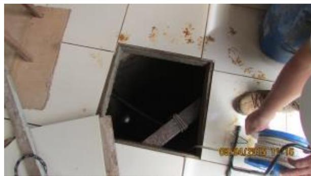
Obs.: a base de concreto foi retirada, atualmente a cisterna está nivelada com o piso; se observou que a água com sabão utilizada para lavar a garagem cai dentro da cisterna.
