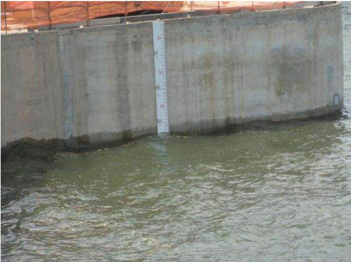
**Figura 11.1.2 - 43 – Vista da régua limnimétrica instalada no Sítio Pimental na face de montante do vertedouro.**
