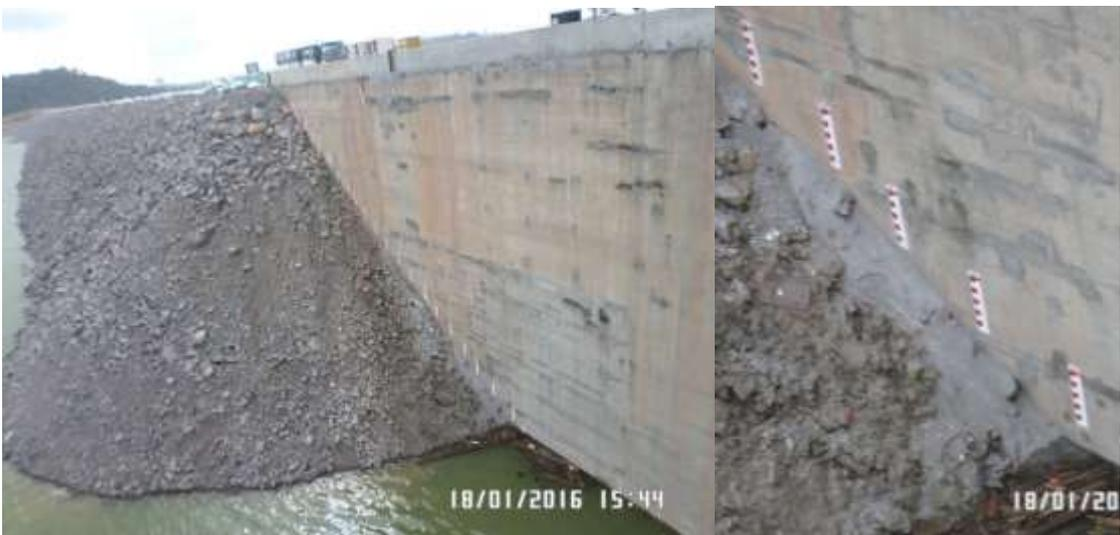
**Figura 11.1.2 - 44 – Vistas da régua limnimétrica instalada na face do muro esquerdo da Tomada de Água do Sítio Belo Monte.**
