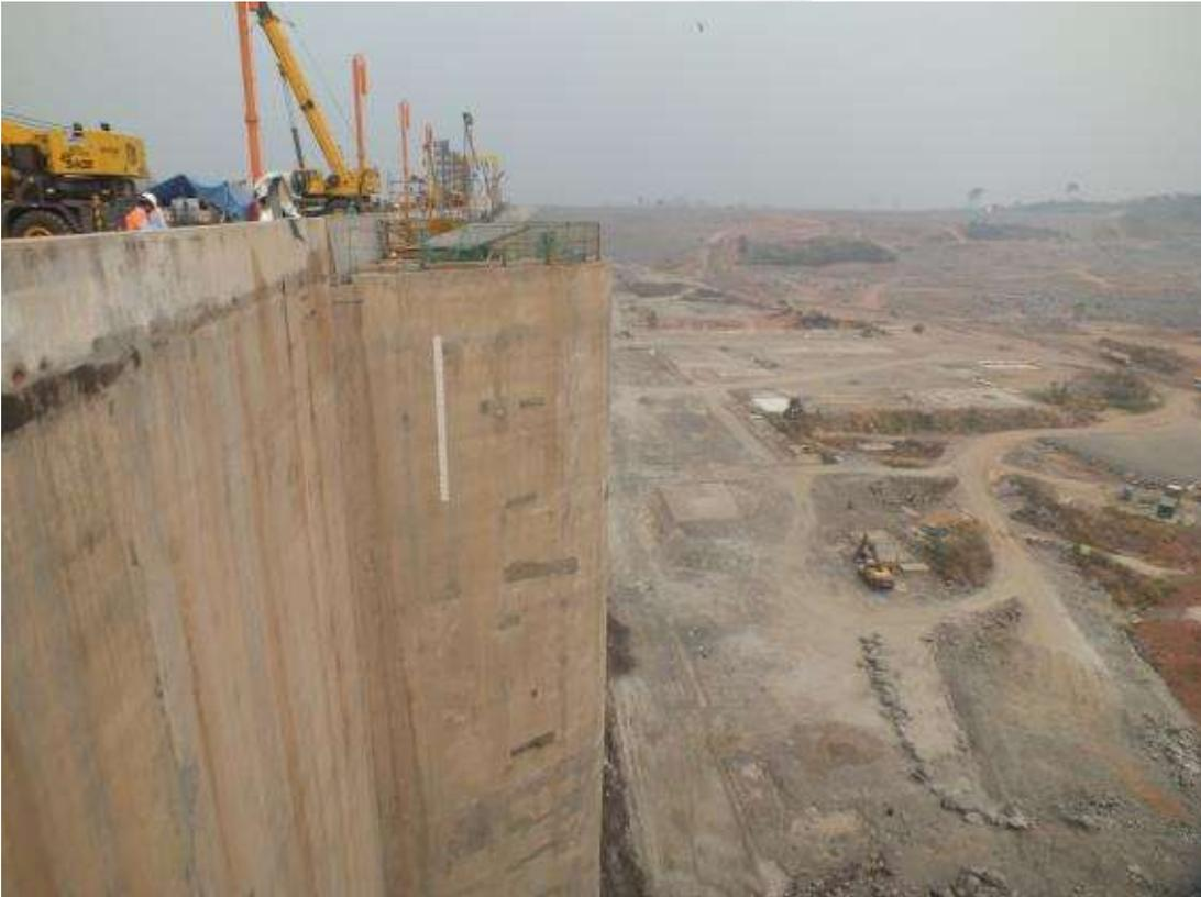
**Figura 11.1.2 - 45 – Vista da régua limnimétrica instalada a montante da Tomada de Água do Sítio Belo Monte antes do início do enchimento do Reservatório Intermediário.**
