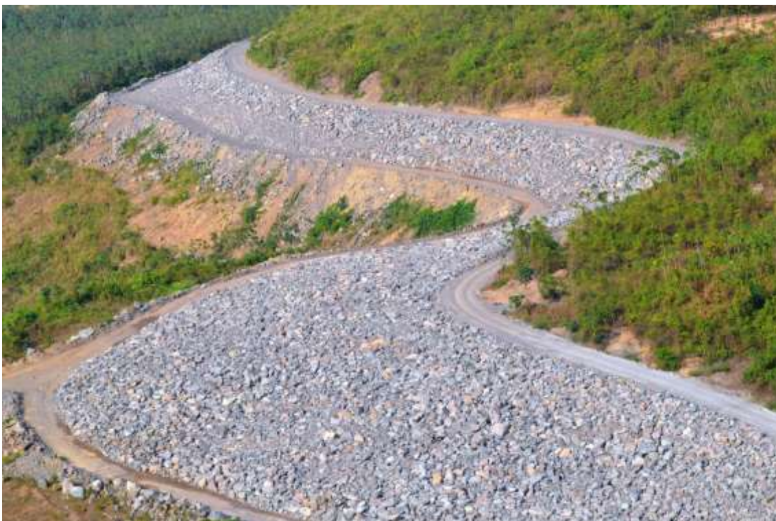
Figura 10.4 - 2 – Detalhe de um trecho de construção de rip-rap no Espigão de Arenito, em dezembro de 2015.
