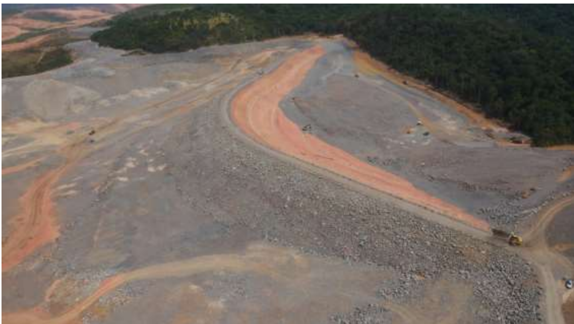
Figura 10.4 - 8 – Vista aérea do Dique 8B em março de 2015.
