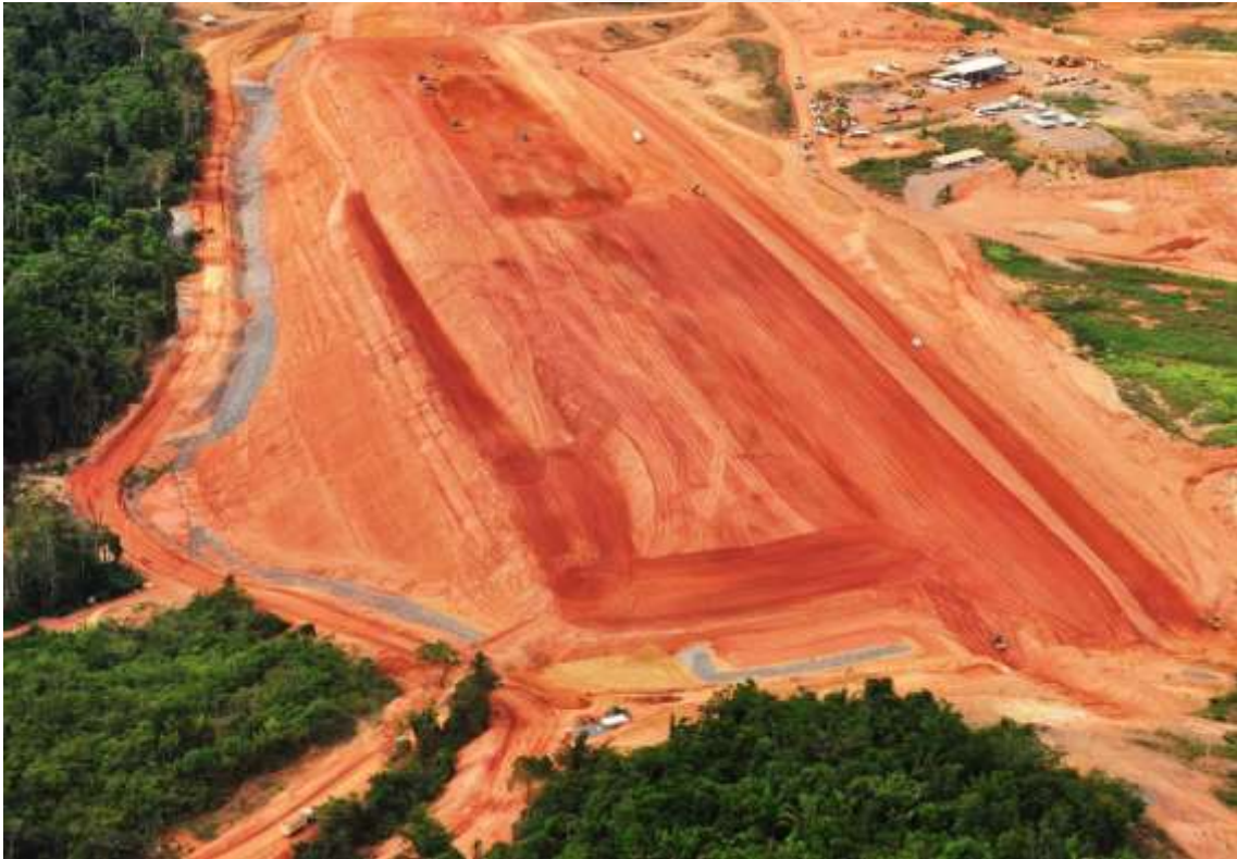
Figura 10.4 - 3 – Vista aérea do Dique 6C em janeiro de 2015.
