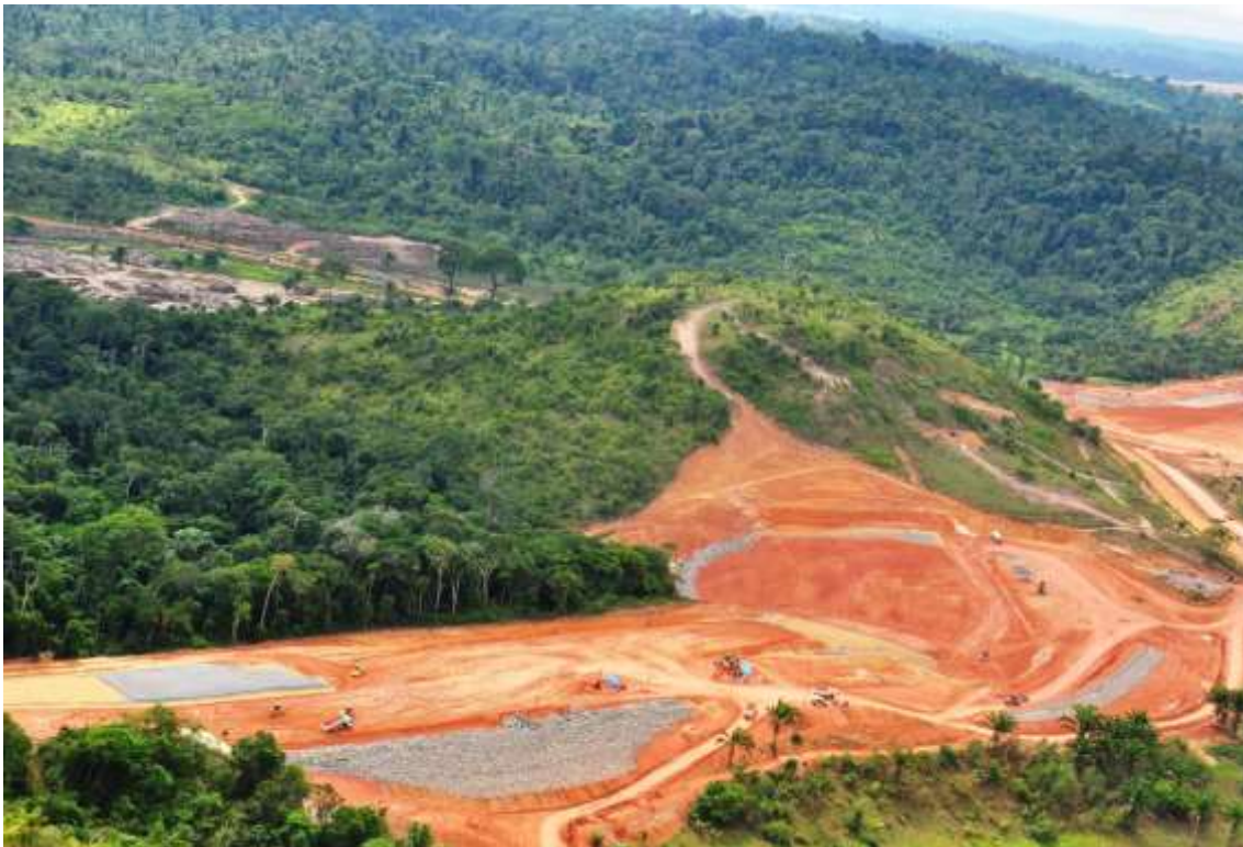
Figura 10.4 - 7 – Vista aérea do Dique 8B em janeiro de 2015.
