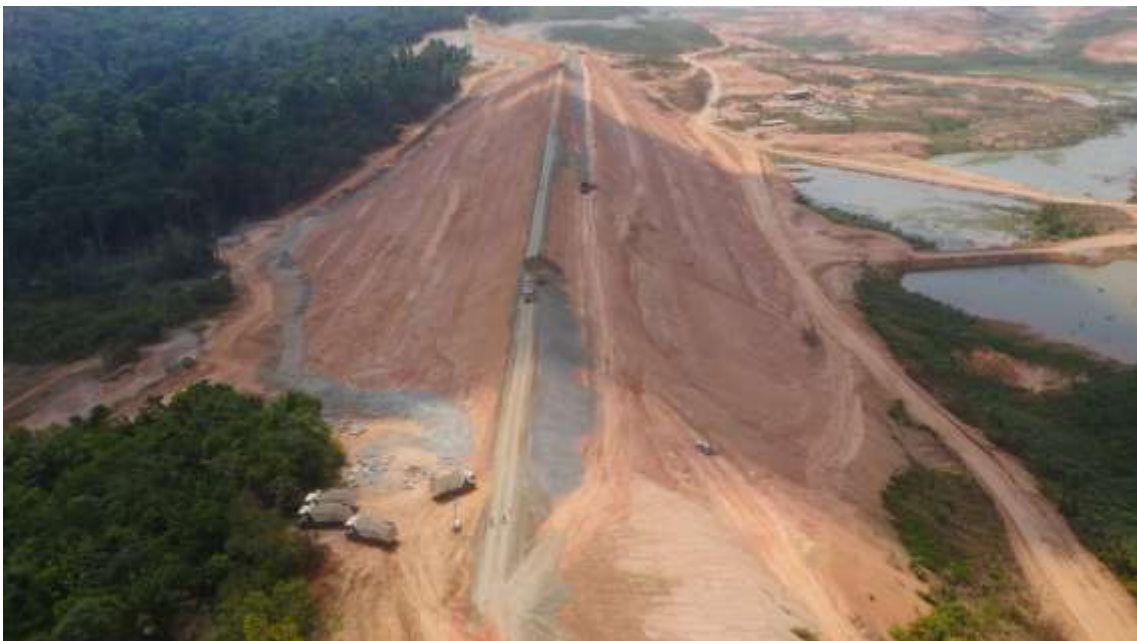
Figura 10.4 - 4 – Vista aérea do Dique 6C em novembro de 2015.
