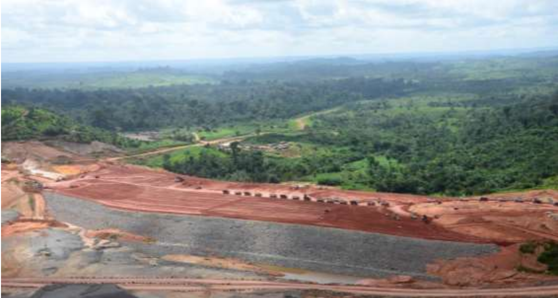
Figura 10.4 - 5 – Vista aérea do Dique 8A em maio de 2015.
