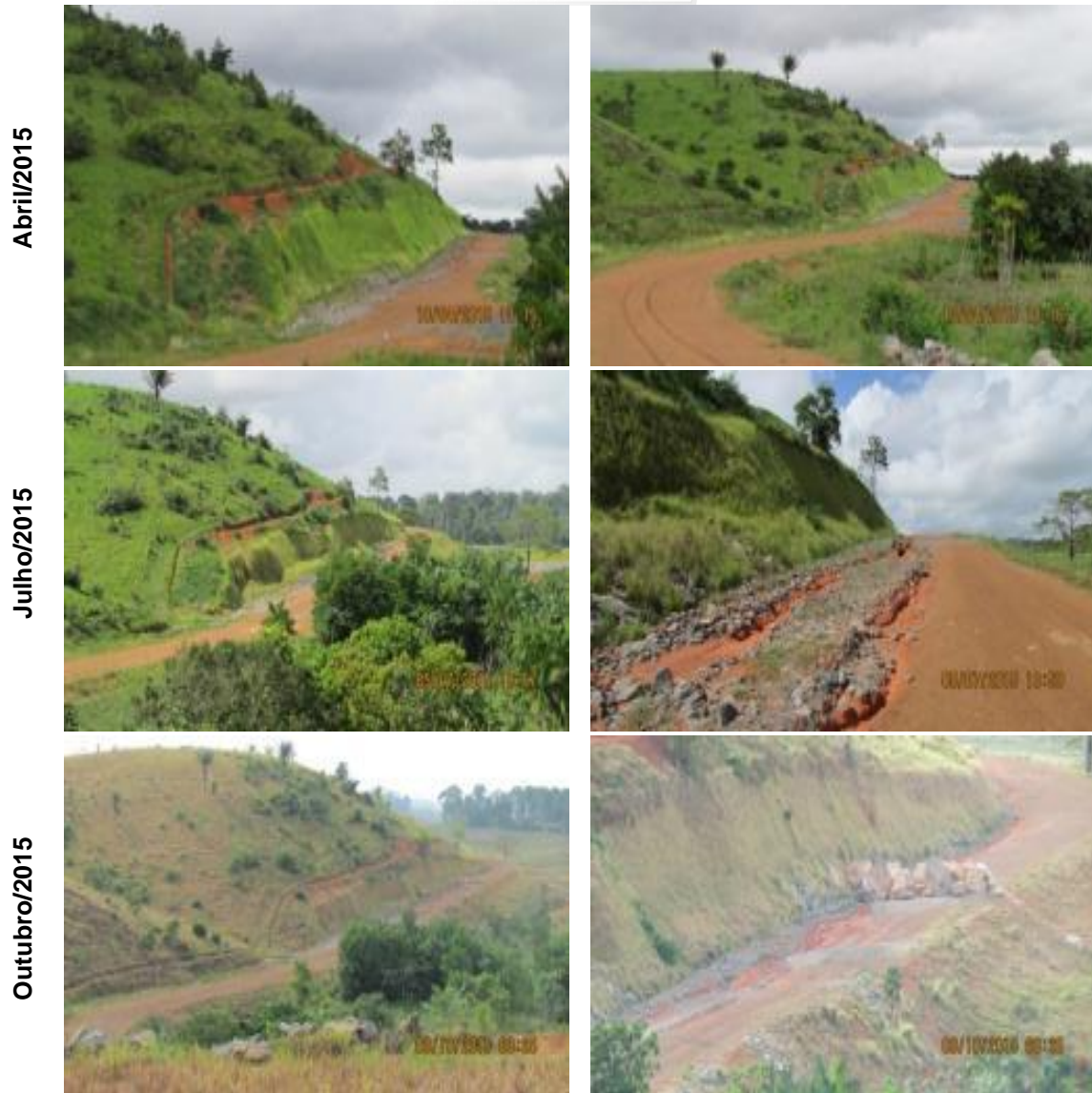
Figura 10.3 - 6 – Vista geral do ponto CS25 (Travessão 45) durante as quatro inspeções trimestrais realizadas em 2015.
