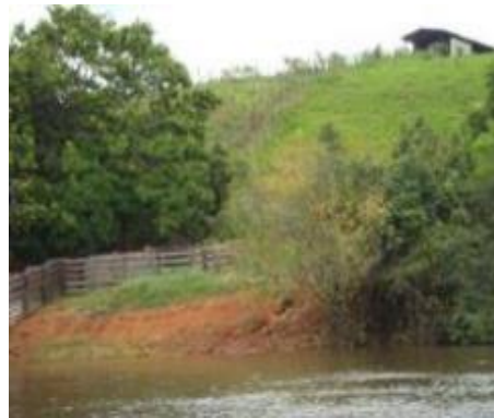
Inspeção Trimestral 8 (janeiro/2014 - enchente): Área aparentemente estável, mesmo com a elevação do nível do rio, notando-se apenas uma redução da exposição do talude.
