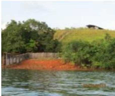
Inspeção Trimestral 7 (outubro/2013 - seca): Área aparentemente estável, sem mudança de risco geotécnico em relação aos valores originais.
