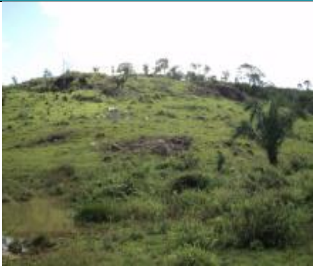
Inspeção Trimestral 1 (maio/2012 - cheia): Encosta vegetada (pasto) com matacões residuais de rocha do embasamento cristalino quartzo-feldspática na superfície, com possível processo de risco geotécnico associado ao rolamento de matacões.
