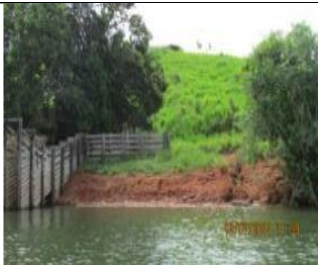
Inspeção Trimestral 10 (julho/2014 - vazante): Área aparentemente estável sob o ponto de vista geotécnico. Observa-se redução da exposição do talude devido ao rebaixamento do nível do rio Xingu em relação à vistoria anterior.
