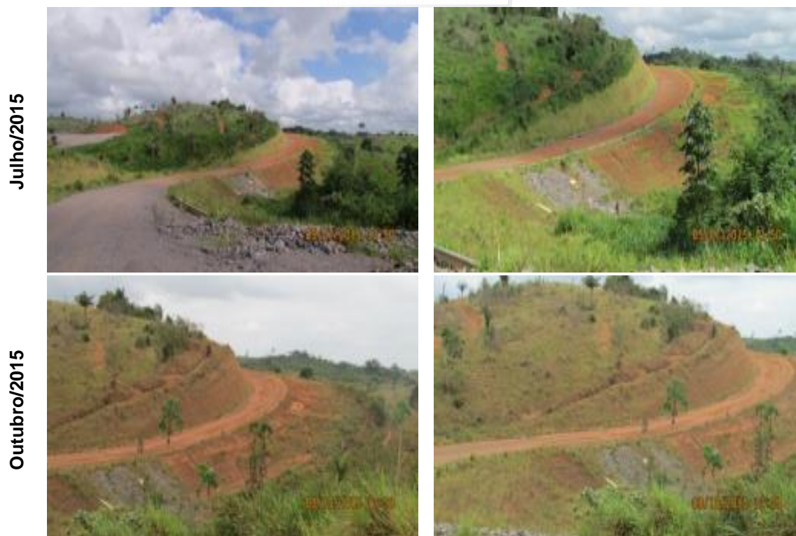
Figura 10.3 - 5 – Vista geral do ponto CS24 durante as quatro inspeções trimestrais realizadas em 2015.
