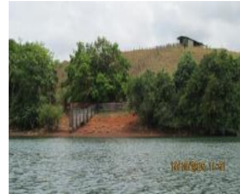
Inspeção Trimestral 15 (outubro/2015 - seca): Área aparentemente estável. Maior exposição do talude devido ao rebaixamento da lâmina d'água.
