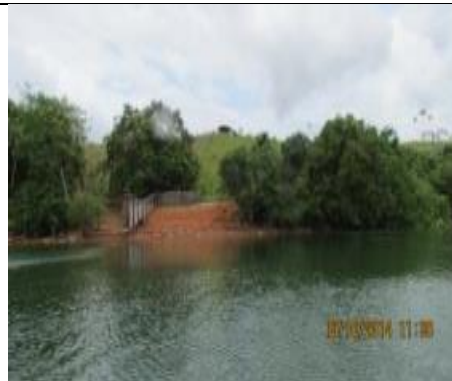
Inspeção Trimestral 11 (outubro/2014 - seca): Área aparentemente estável. Devido ao rebaixamento do nível do rio observa-se maior exposição do talude em relação à vistoria anterior. Pouca diferenciação de características em relação às visitas anteriores em épocas similares.
