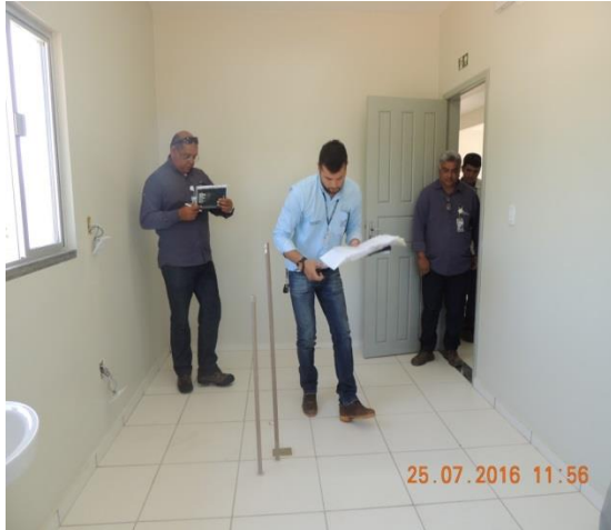
Figura 10.1.2.1-5 - Checklist UBSI Aldeia Paquiçamba - TI Paquiçamba. Verificação da parte elétrica, hidráulica e esgoto do consultório odontológico.
