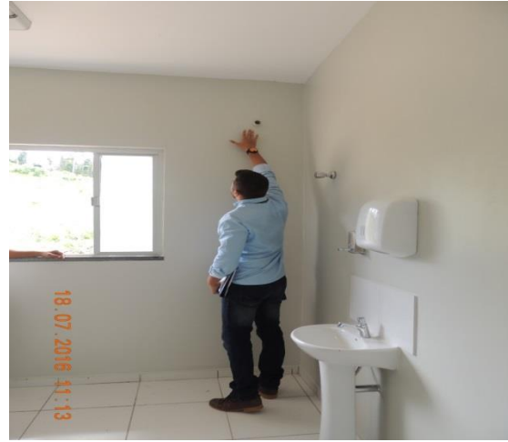
Figura 10.1.2.1-4 - Checklist UBSI Aldeia Furo Seco. Verificação da pintura das paredes e tubulação para centrais de ar.
