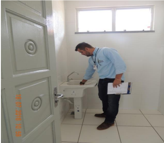
Figura 10.1.2.1-3 - Checklist UBSI Aldeia Furo Seco - TI Paquiçamba. Verificação da saída de água na torneira.
