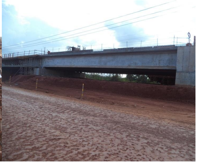
Ponte Transamazônica 1 – Ambé – 17.06.2015
