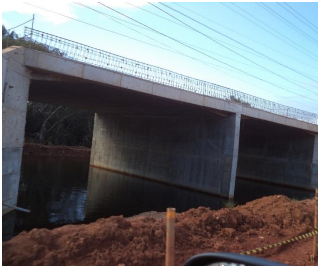
Ponte Transamazônica 2 – Ambé – 17.06.2015
