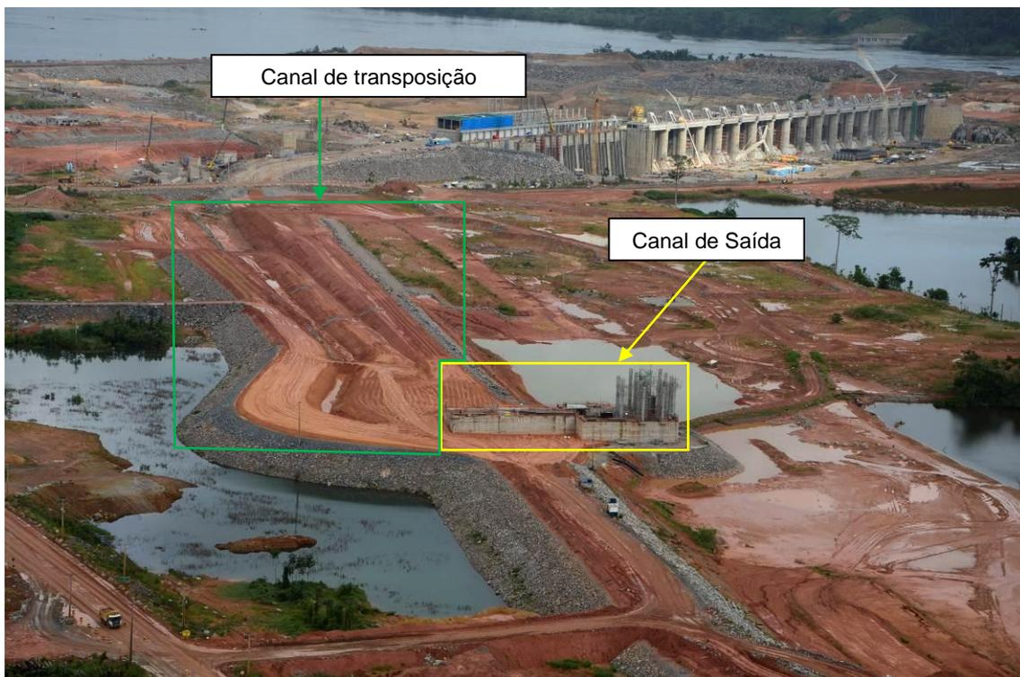
**Figura - 1 – Vista geral das estruturas do canal de transposição e canal de saída do STP**
