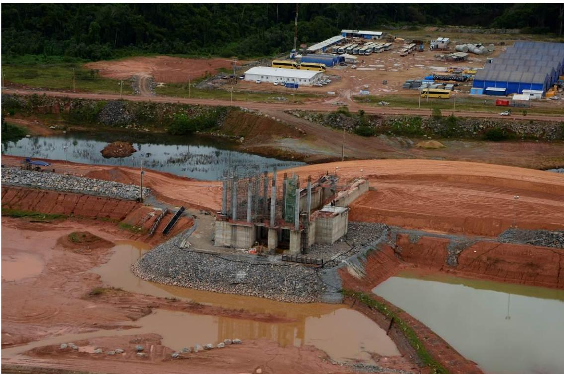
**Figura - 3 – Vista mais aproximada do canal de saída do STP, que fará a ligação entre o canal de transposição e o reservatório**
