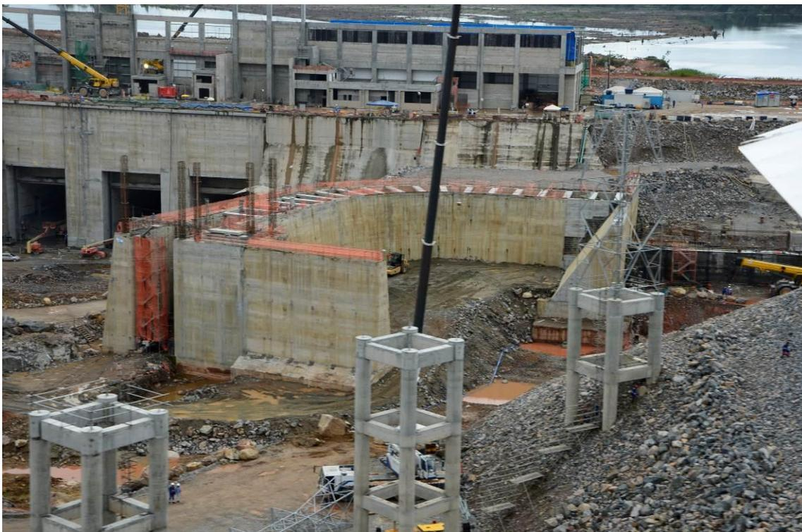
**Figura - 5 - Detalhe do canal de entrada em construção do STP**
