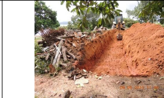
Figura 124 – Abertura de vala - Data: 08/06/2015
