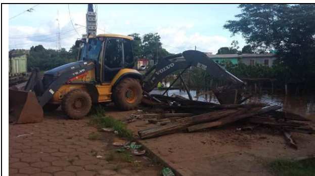
Figura 79 – demolição em áreas alagadas - Data: 15/04/2015
