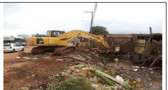
Figura 62 – Limpeza e retirada de material - Data: 07/04/2015
