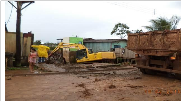
Figura 15 - Limpeza e retirada de material - Data: 18/02/2015
