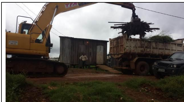
Figura 39 – Limpeza e retirada de material - Data: 11/03/2015
