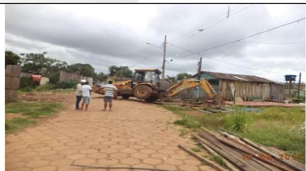
Figura 36 – Limpeza e retirada de material - Data: 10/03/2015
