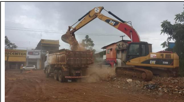
Figura 33 – Limpeza da área - Data: 04/03/2015
