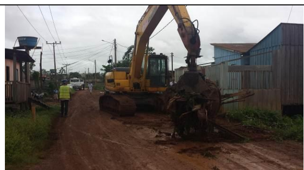
Figura 38 - Área após realização de limpeza - Data: 11/03/2015
