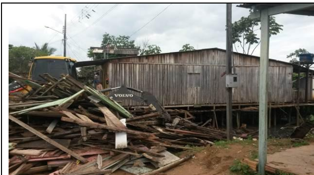
Figura 09 – Demolição e Limpeza - Data: 12/02/2015
