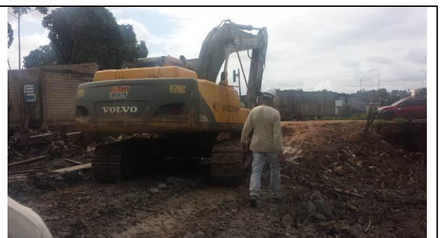
Figura 06 – Demolição e Limpeza - Data: 06/02/2015
