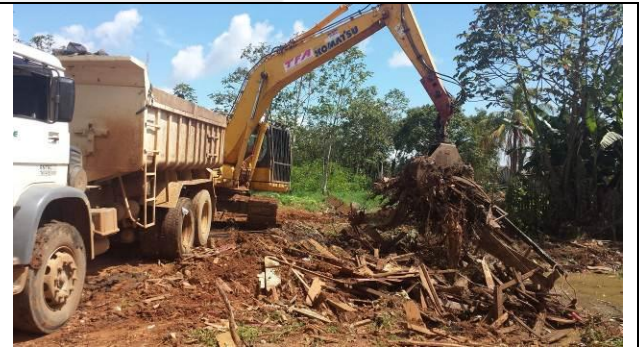
Figura 82 – Demolição e limpeza - Data: 24/04/2015
