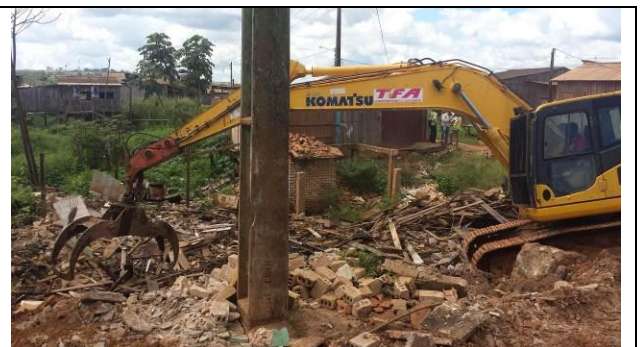
Figura 28 – Demolição e limpeza - Data: 03/03/2015
