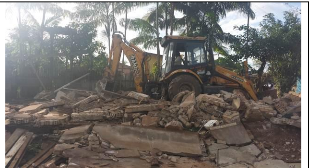
Figura 04 – Demolição e Limpeza - Data: 04/02/2015
