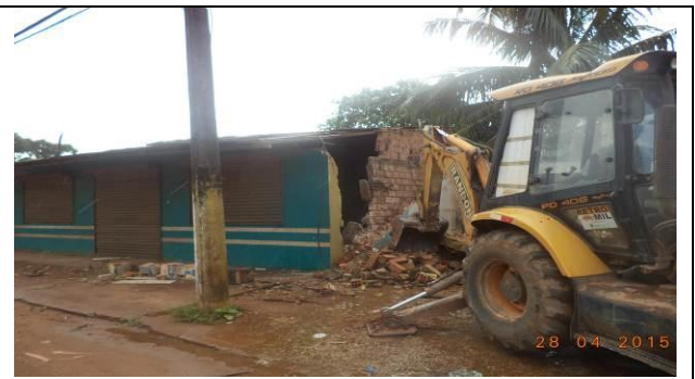
Figura 84– Demolição e limpeza - Data: 28/04/2015
