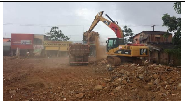
Figura 32 – Limpeza da área - Data: 04/03/2015
