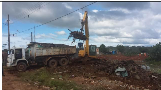
Figura 76 – Demolição e limpeza - Data: 15/04/2015
