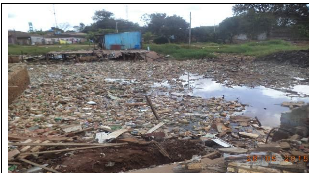
Figura 97 – Vista do local antes da realização de limpeza - Data: 28/5/2015
