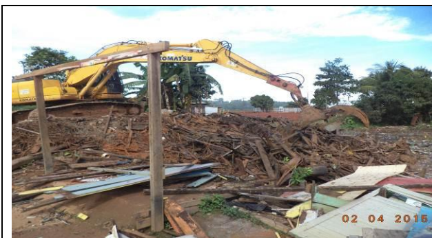
Figura 53 - Demolição e limpeza - Data: 02/04/2015
