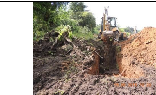
Figura 128 – Abertura de vala - Data: 16/6/2015
