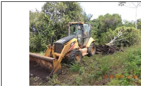
Figura 127 – Demolição e Limpeza - Data: 15/6/2015
