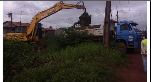
Figura 42 – Demolição e limpeza - Data: 11/03/2015
