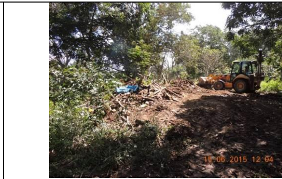
Figura 126 - Demolição e Limpeza - Data: 15/6/2015
