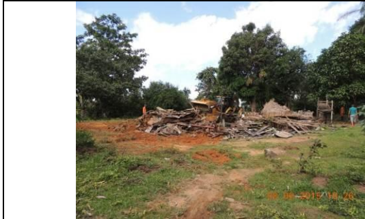
Figura123 - Demolição e Limpeza - Data: 08/06/2015
