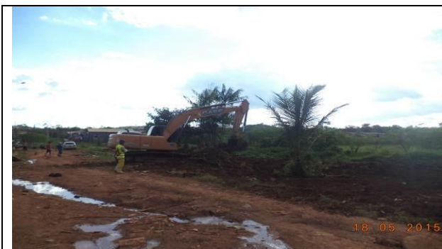
Figura 93 – Limpeza de área - Data: 18/5/2015
