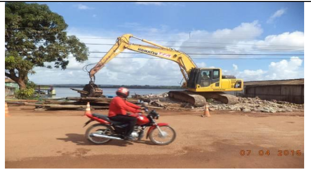
Figura 64 - Demolição e limpeza - Data: 07/04/2015
