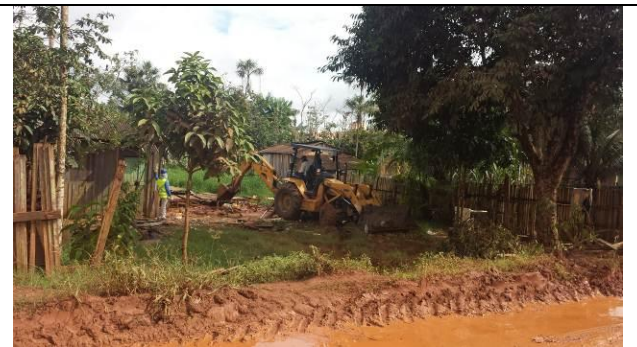
Figura 20 - Demolição e limpeza - Data: 23/02/2015
