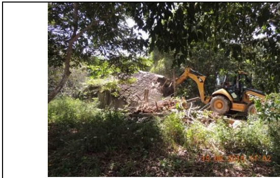
Figura 125 - Demolição e Limpeza - Data: 15/6/2015
