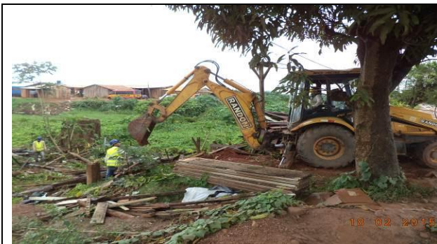
Figura 17 - Limpeza e retirada de material - Data: 18/02/2015
