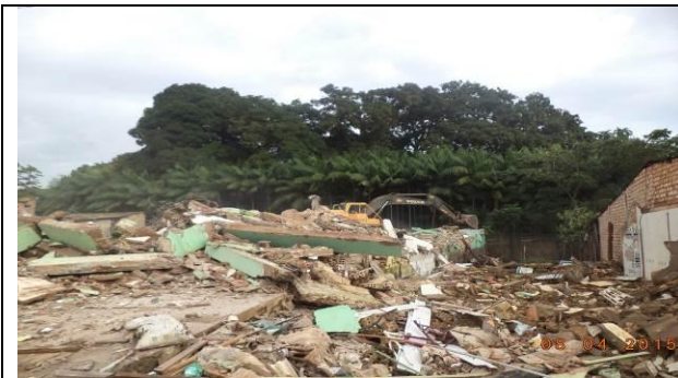
Figura 65 – Demolição e limpeza - Data: 08/04/2015
