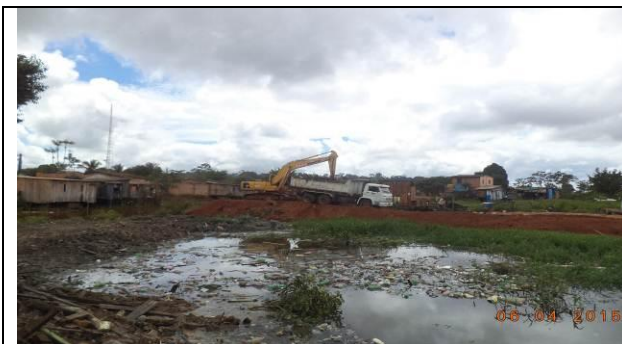
Figura 59 – Limpeza da área - Data: 06/04/2015
