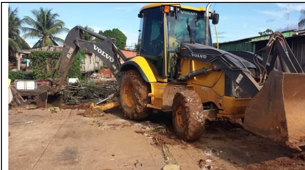
Figura 75 – Demolição e limpeza - Data: 14/04/2015
