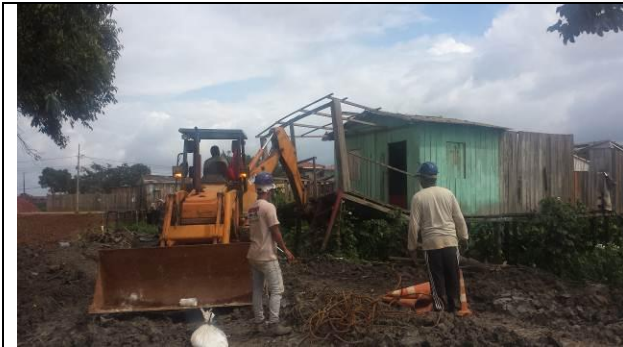
Figura 07 – Demolição e Limpeza - Data: 06/02/2015
