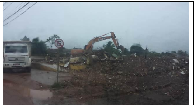
Figura 44 – Demolição e limpeza - Data: 16/03/2015
