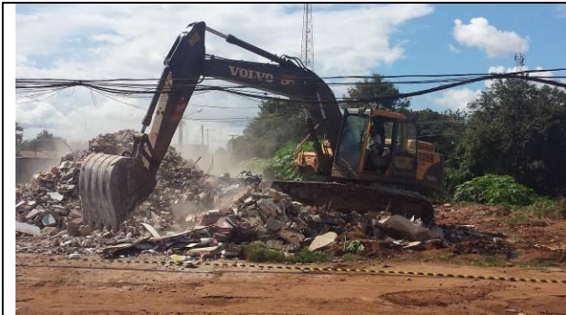
Figura 21 – Demolição e limpeza - Data: 25/02/2015
