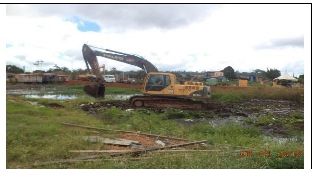
Figura 58 – Limpeza da área - Data: 06/04/2015
