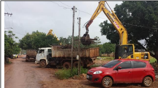
Figura 91 – Demolição e limpeza - Data: 08/5/2015
