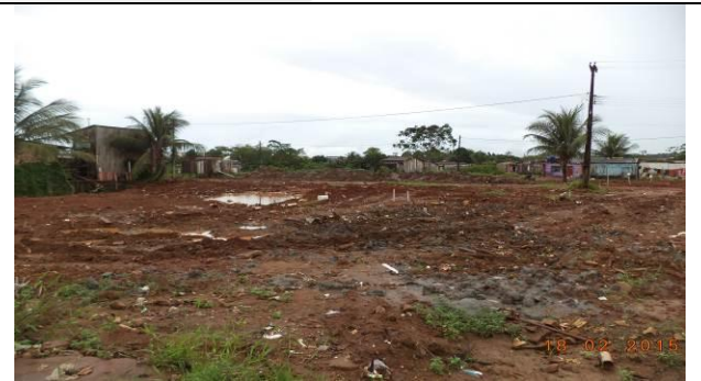
Figura 16 - Área após realização de limpeza - Data: 18/02/2015
