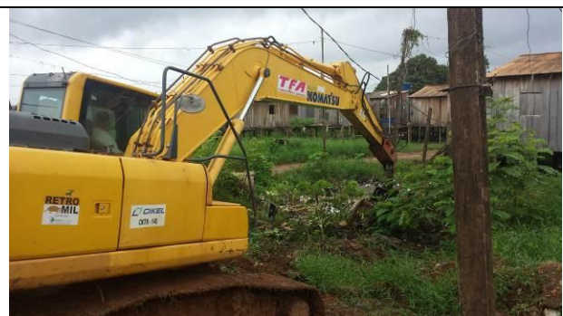
Figura 40 – Demolição e limpeza - Data: 11/03/2015
