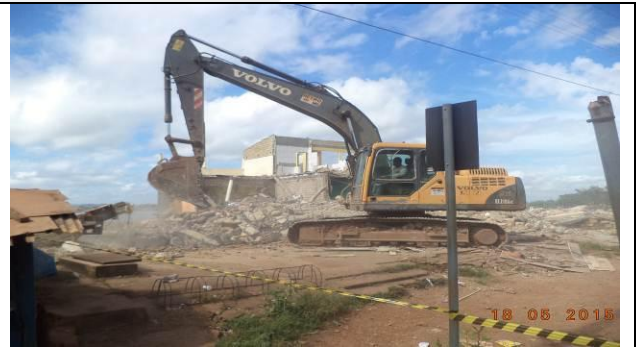
Figura 92 – Demolição e limpeza - Data: 18/5/2015
