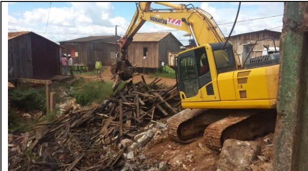
Figura 29 – Demolição e limpeza - Data: 03/03/2015
