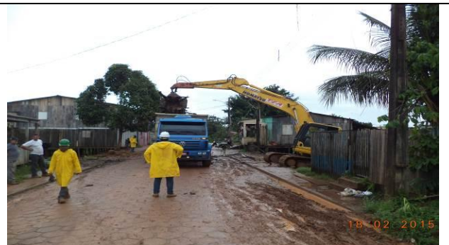
Figura 12 – Limpeza e retirada de material - Data: 18/02/2015
