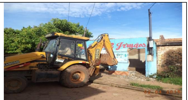
Figura 54 – Demolição e limpeza - Data: 02/04/2015
