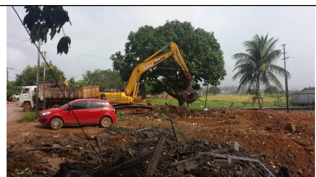
Figura 90 – Demolição e limpeza - Data: 08/5/2015
