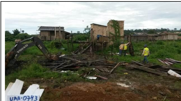
Figura 19 - Limpeza e retirada de material - Data: 18/02/2015
