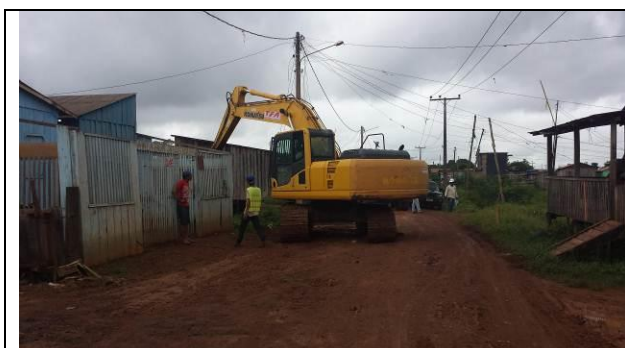
Figura 37 - Limpeza e retirada de material - Data: 11/3/15
