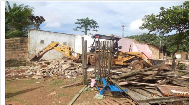
Figura 55 – Demolição e limpeza - Data: 06/04/2015
