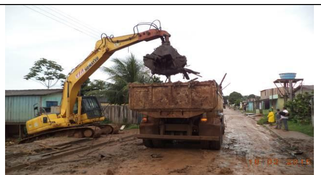
Figura 14 – Limpeza e retirada de material - Data: 18/02/2015
