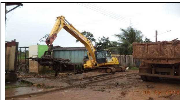
Figura 13 – Limpeza e retirada de material - Data: 18/02/2015
