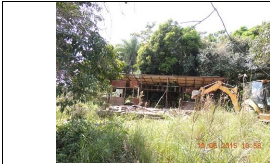
Figura 131 - Demolição e Limpeza - Data: 19/6/2015
