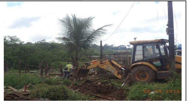
Figura 56 – Demolição e limpeza - Data: 06/04/2015
