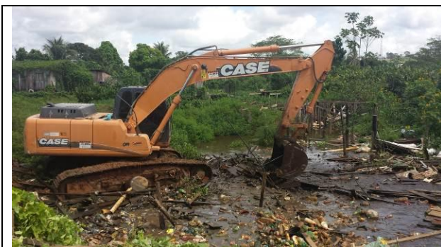
Figura 107 – Demolição e limpeza - Data: 03/6/2015
