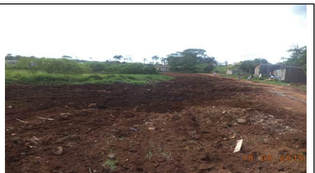
Figura 94 – Local após limpeza - Data: 18/5/2015
