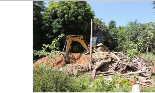
Figura 132 - Abertura de vala - Data: 19/6/2015
