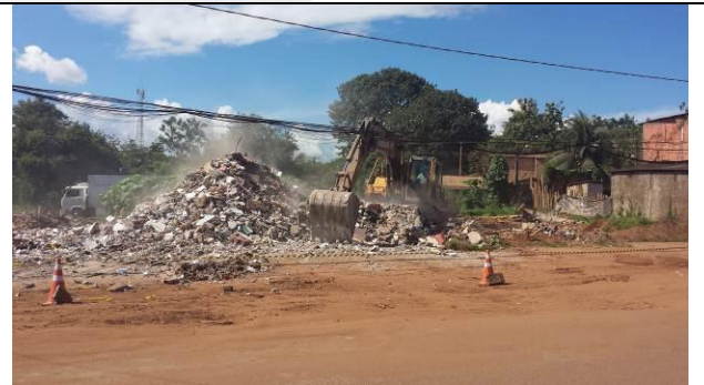
Figura 22 – Demolição e limpeza - Data: 25/02/2015
