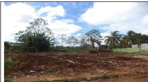
Figura 57 – Demolição e Limpeza - Data: 06/04/2015
