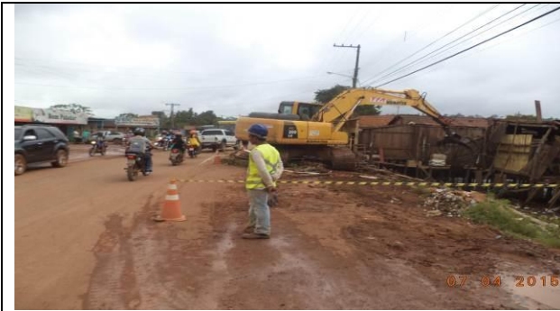
Figura 63 - Limpeza e retirada de material - Data: 07/04/2015
