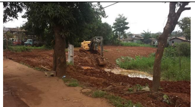
Figura 10 – Limpeza da área - Data: 12/02/2015
