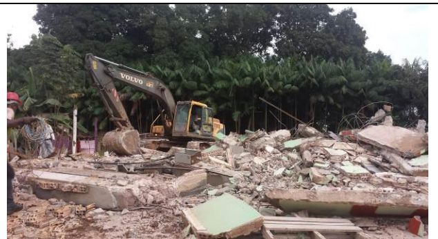
Figura 66 – Demolição e limpeza - Data: 08/04/2015
