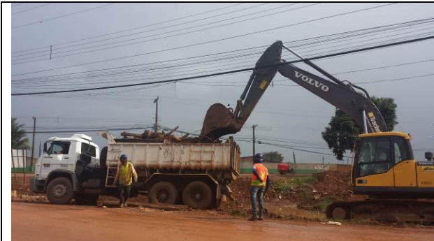
Figura 01 – Limpeza de área - Data: 04/02/2015
