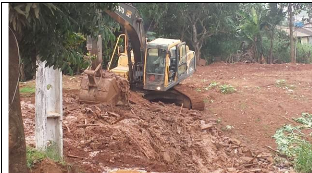
Figura 11 – Limpeza da área - Data: 12/02/2015
