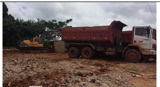
Figura 72 – Limpeza e retirada de material - Data: 09/04/2015
