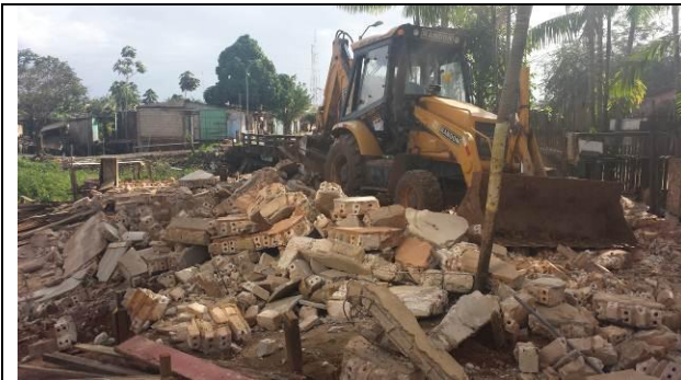
Figura 03 – Demolição e Limpeza - Data: 04/02/2015
