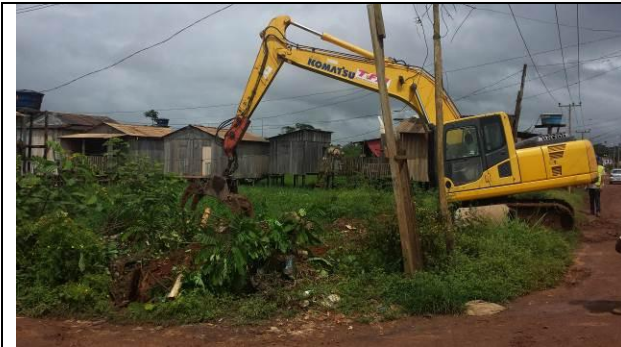
Figura 41 - Limpeza e retirada de material - Data: 11/03/2015
