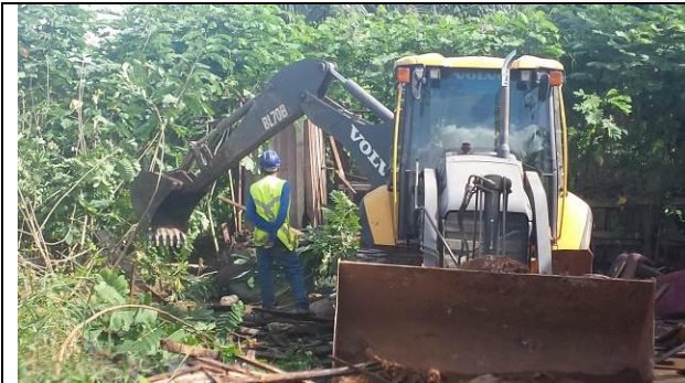
Figura 81 – Demolição e limpeza - Data: 17/04/2015
