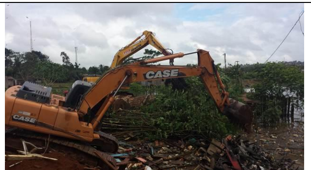
Figura 68 – Limpeza e retirada de material - Data: 08/04/2015
