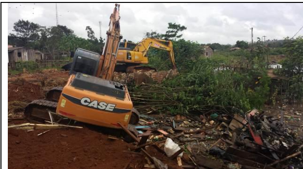
Figura 67 - Limpeza e retirada de material - Data: 08/04/2015
