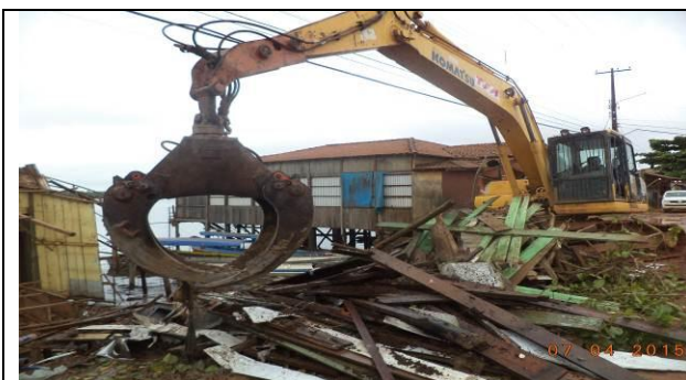
Figura 61 – Demolição e limpeza - Data: 07/04/2015
