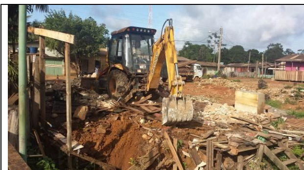
Figura 05 - Demolição e Limpeza - Data: 04/02/2015
