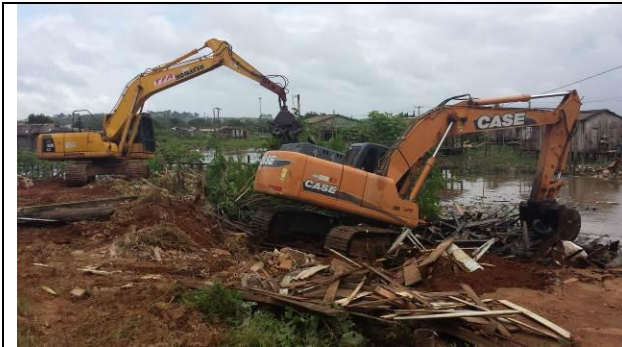
Figura 69 – Limpeza e retirada de material - Data: 08/04/2015
