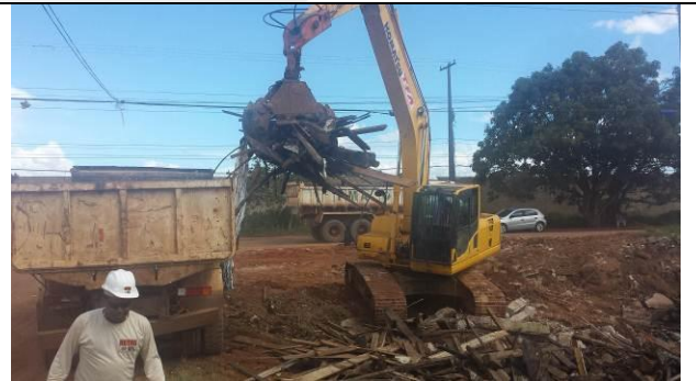
Figura 30 – Demolição e limpeza - Data: 03/03/2015
