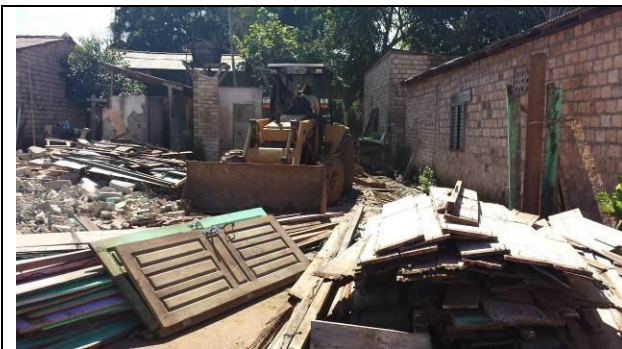
Figura 31 – Demolição e Limpeza - Data: 03/03/2015
