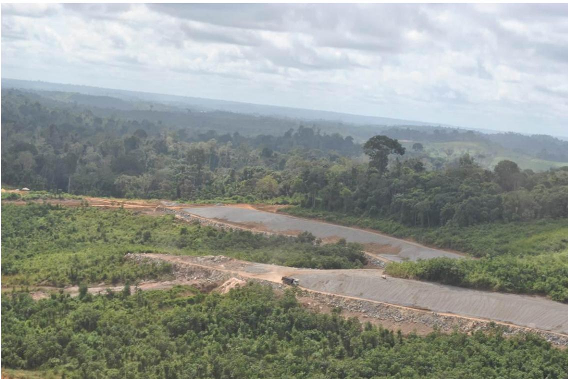
Foto 7 – Vista geral do trecho de construção de *rip-rap* no Espigão de Arenito.
