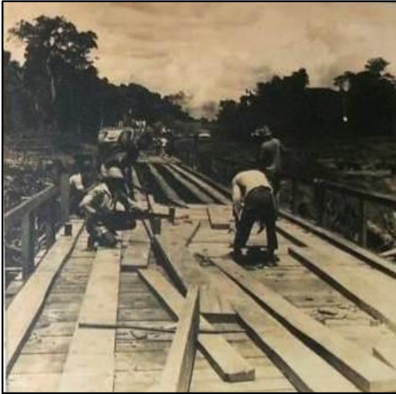
Figura 20 – Construção de ponte de madeira sobre a rodovia Transamazônica. Fonte: Acervo do DNIT/Altamira.
