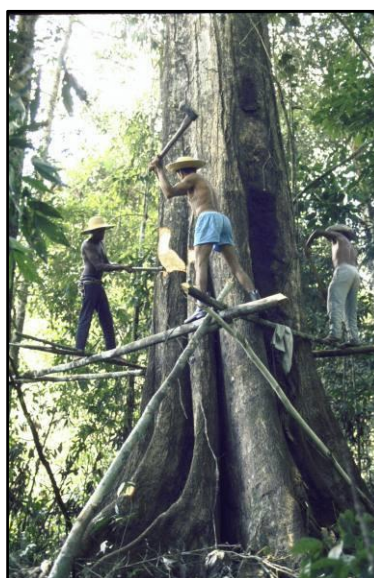
Figura 13 – Derrubada de árvore para a construção da rodovia Transamazônica, 1971. Foto: John Domini. Fonte: Acervo Revista Life.
