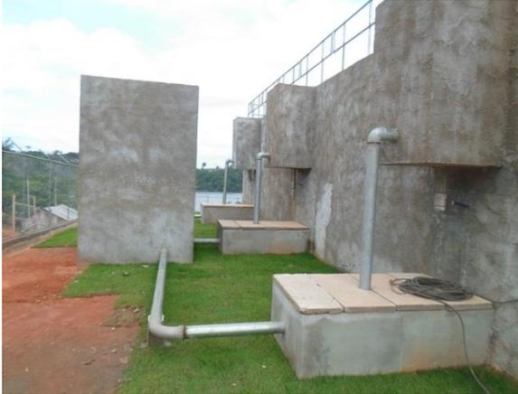
**Figura 5.3.19 - 1 – Caixa de saída e dosadora química água tratada em Belo Monte.**
