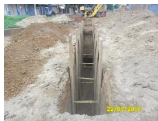
Figura 5.1.9-16 – Vala com escoramento
