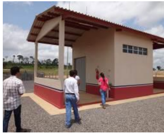
Figura 5.1.9-8 – Abrigo da Autoclave Fonte: WorleyParsons 2014.
