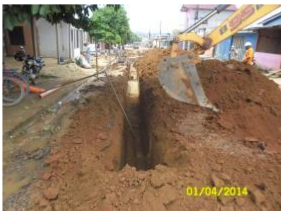
Figura 5.1.9-13 – Abertura de Vala
