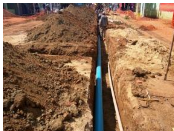
Figura 5.1.9-14 – Assentamento de tubulação
