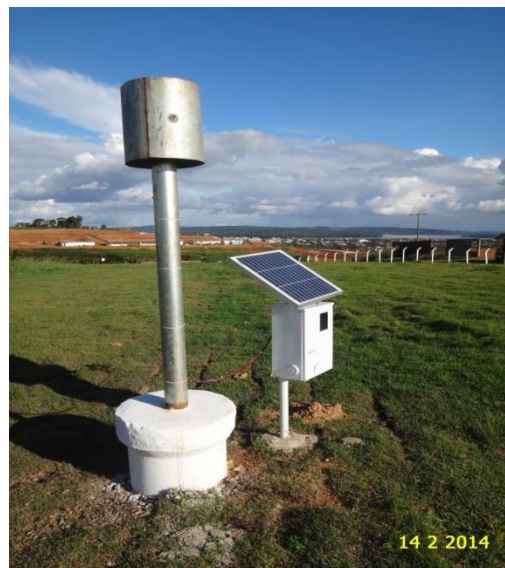
Figura 5.1.9-2 – Queimador de biogás
