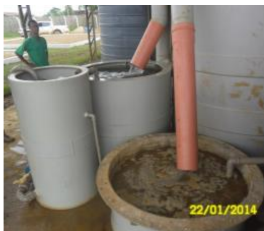
Figura 5.1.9-4 – Lixiviados em tratamento
