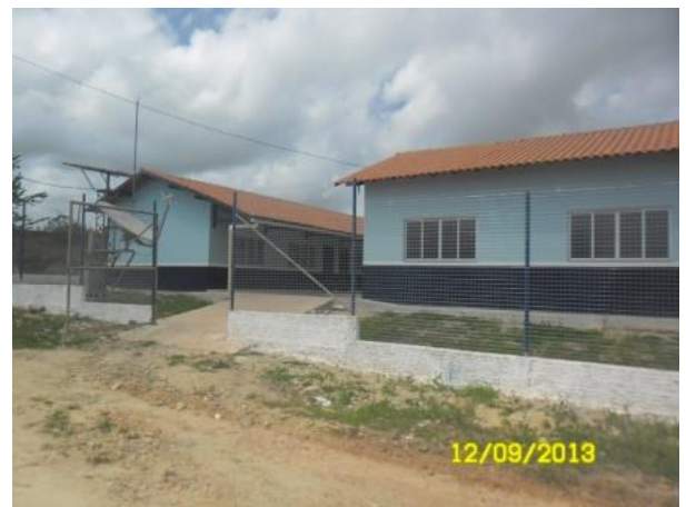
Figura 98 - Conclusão da obra de reforma com ampliação da EMEF Salomão Eschrique - Senador José Porfírio/PA.
