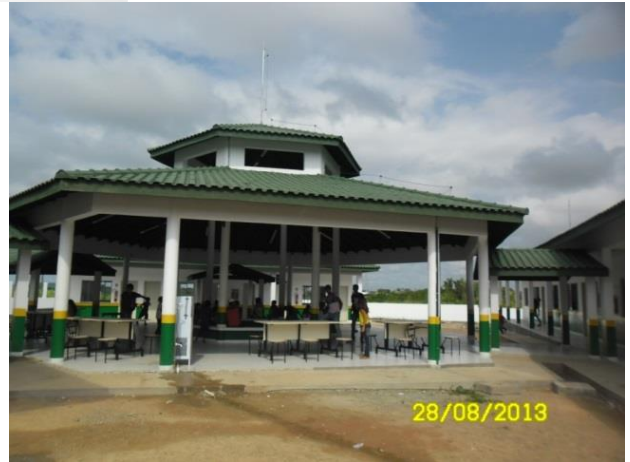
Figura 76 - Conclusão da obra de construção da EMEF Dr. Acy de Jesus B. Pereira - Vila Isabel - Anapu/PA.
