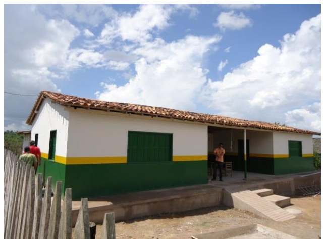
Figura 56 - Conclusão da obra de reforma da Escola Rural Boa Esperança II - Vitória do Xingu/PA.
