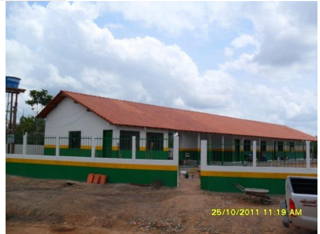
Figura 54 - Conclusão da obra de construção da Escola Planaltina - Vitória do Xingu/PA.
