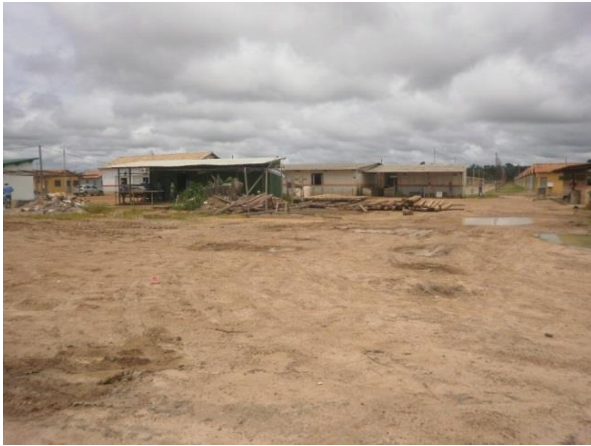
Figura 19 - Terreno antes da construção da EMEI Nova Altamira - Altamira/PA.
