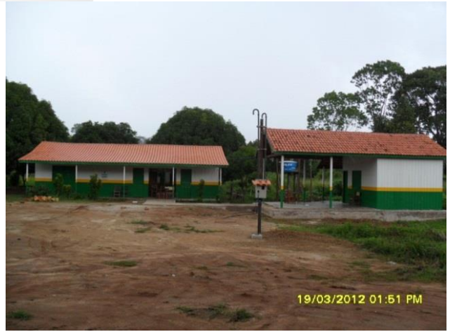
Figura 66 - Conclusão da obra de reforma com ampliação da Escola São Raimundo Nonato - Vitória do Xingu/PA.
