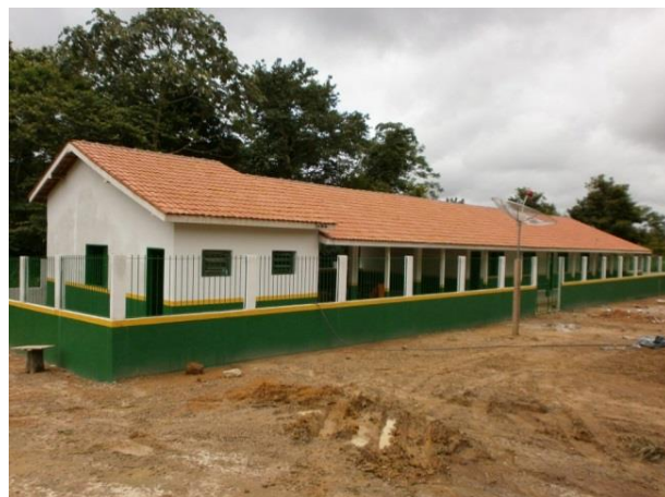
Figura 50 - Conclusão da obra de construção da Escola Vila Rica - Vitória do Xingu/PA.
