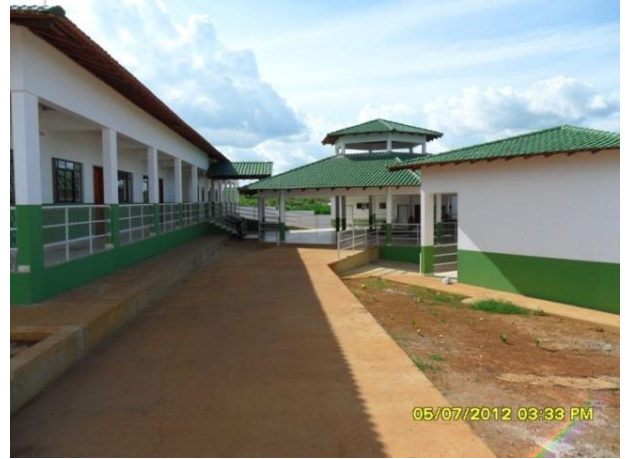
Figura 26 - Conclusão da obra de construção da EMEI Jardim França - Altamira/PA.
