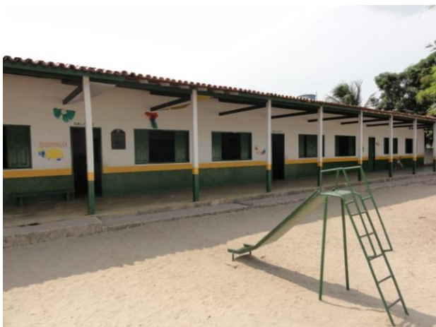
Figura 35 - EMEI Domingas Fortunato antes da obra de reforma com ampliação - Vitória do Xingu/PA.
