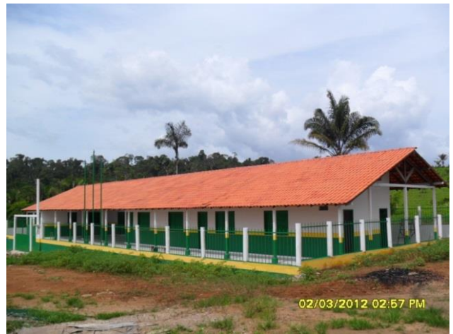
Figura 68 - Conclusão da obra de reforma com ampliação da Escola Duque de Caxias - Vitória do Xingu/PA.
