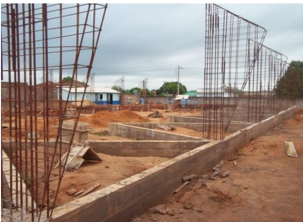
Figura 85 - Início da obra de construção da Quadra Poliesportiva da EMEF Paraíso - Brasil Novo/PA.
