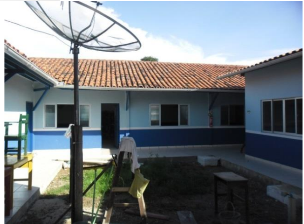
Figura 94 - Conclusão da obra de reforma com ampliação da EMEF Francisco Merêncio - Senador José Porfírio/PA.
