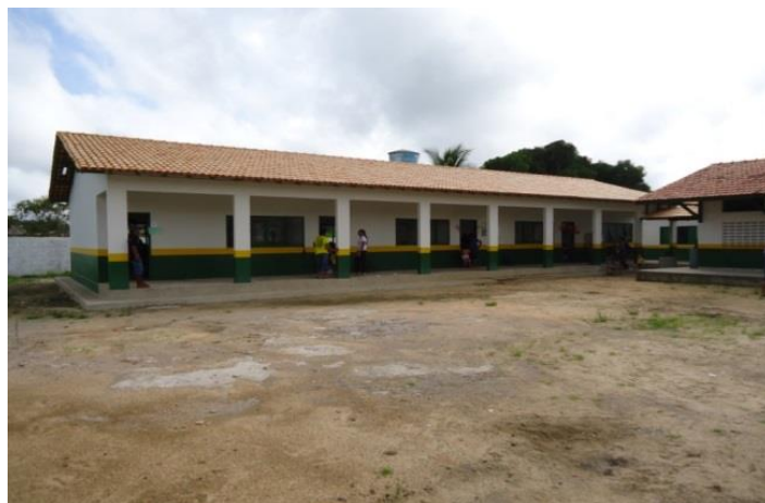
Figura 36 - Conclusão da obra de reforma com ampliação da EMEI Domingas Fortunato - Vitória do Xingu/PA.
