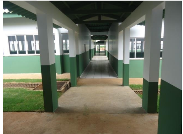
Figura 14 - Conclusão da obra de reforma com ampliação EMEF Saint Clair Passarinho - Altamira/PA.
