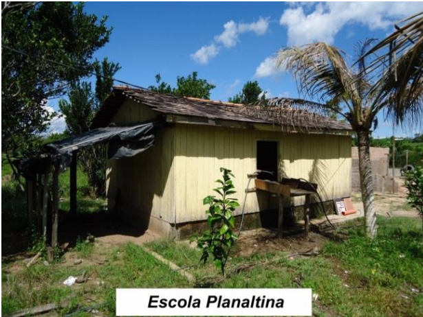
Figura 53 - Escola Planaltina antes da obra de construção - Vitória do Xingu/PA.
