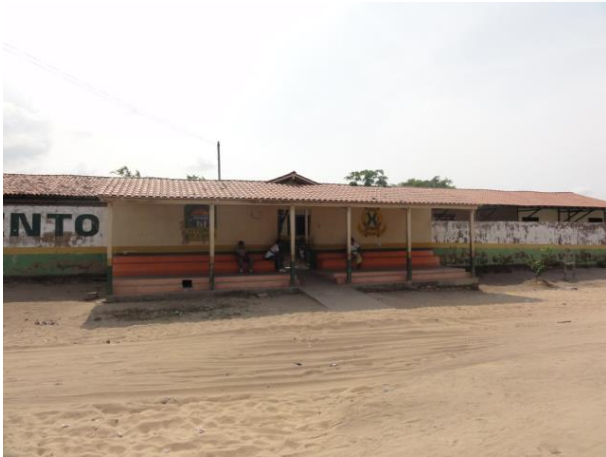
Figura 37 - EMEF Dulcinéia de Almeida do Nascimento antes da obra de reforma com ampliação - Vitória do Xingu/PA.
