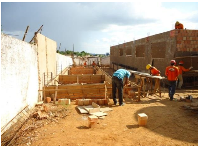
Figura 43 - EMEIF Leonardo da Vinci antes da obra de reforma com ampliação da - Vitória do Xingu/PA.
