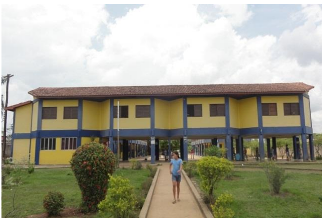
Figura 79 - EMEF Escola Irmã Terezinha Back antes da obra de reforma com ampliação - Brasil Novo/PA.
