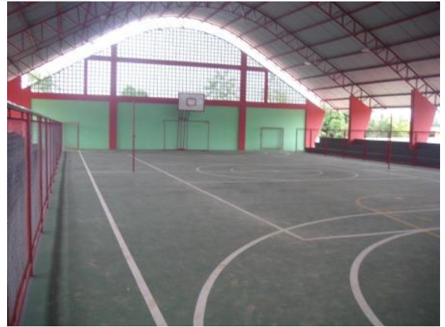
Figura 82 - Conclusão da obra de construção da Quadra Poliesportiva da EMEF Irmã Terezinha Back - Brasil Novo/PA.
