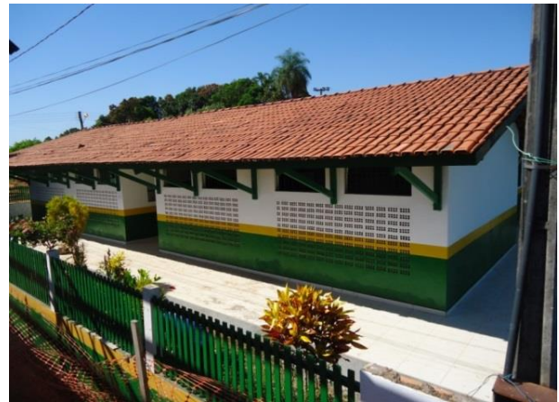
Figura 40 - Conclusão da obra de reforma com ampliação da Escola Evangelho - Vitória do Xingu/PA.
