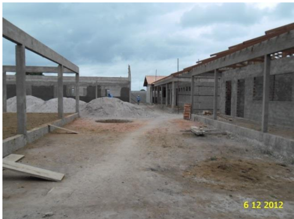
Figura 95 - Início da obra de construção da EMEF 12 salas - Senador José Porfírio/PA.
