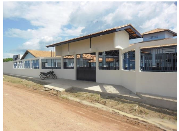
Figura 96 - Conclusão da obra de construção da EMEF 12 salas - Senador José Porfírio/PA.
