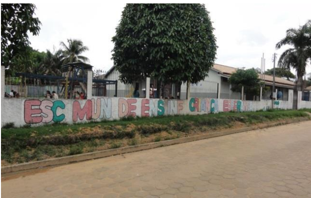
Figura 91 - Creche Criança Esperança - Brasil Novo/PA, antes da obra de reforma com ampliação.
