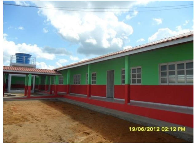
Figura 88 - Conclusão da obra de construção da EMEI Pequeno Cidadão - Brasil Novo/PA.
