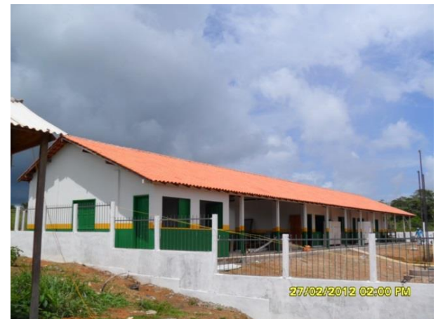
Figura 64 - Conclusão da obra de reforma com ampliação da Escola Bom Jardim I - Vitória do Xingu/PA.
