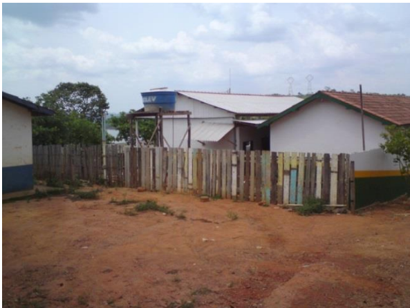
Figura 39 - Escola Evangelho antes da obra de reforma com ampliação - Vitória do Xingu/PA.
