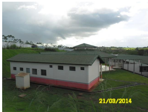
Figura 34 - Conclusão da obra de construção da EMEF Anísio de Araújo Uchôa - Altamira/PA.
