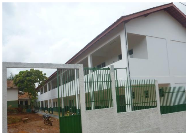
Figura 4 - Conclusão da obra de reforma com ampliação na EMEF Geraldo Emídio Bezerra - Altamira/PA.
