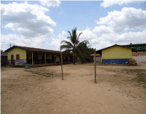
Figura 83 - EMEF Paraíso antes da obra de reforma com ampliação - Brasil Novo/PA.
