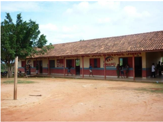
Figura 71 - Escola José Andrade Silva antes da obra de reforma com ampliação - Anapu/PA.
