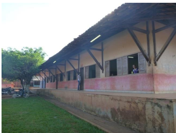
Figura 5 - EMEF João Rodrigues antes da obra de reforma com ampliação - Altamira/PA.
