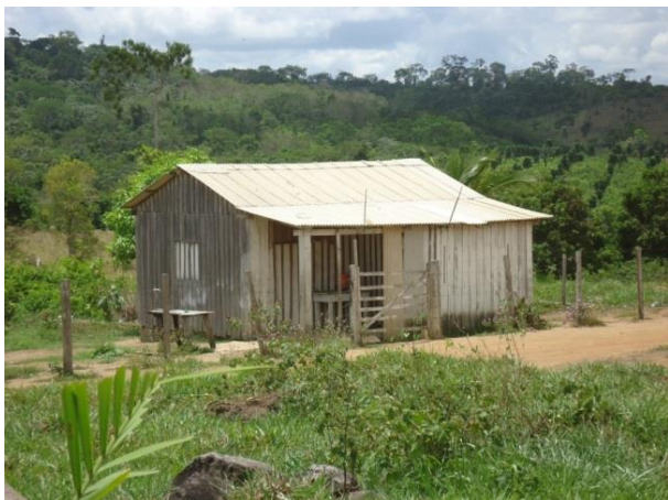
Figura 63 - Escola Bom Jardim I antes da obra de reforma com ampliação - Vitória do Xingu/PA.
