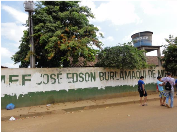
Figura 7 - EMEF José Edson Burlamaqui de Miranda antes da obra de reforma com ampliação - Altamira/PA.
