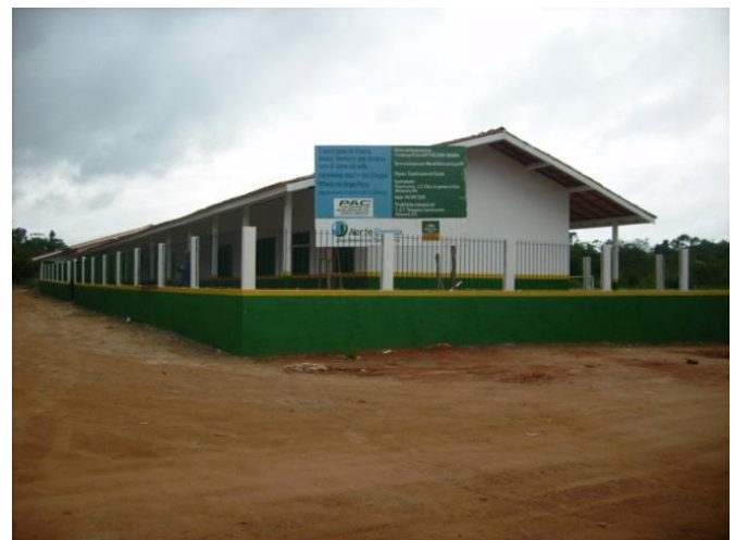
Figura 46 - Conclusão da obra de reforma com ampliação da Escola Nossa Senhora das Graças - Vitória do Xingu/PA.
