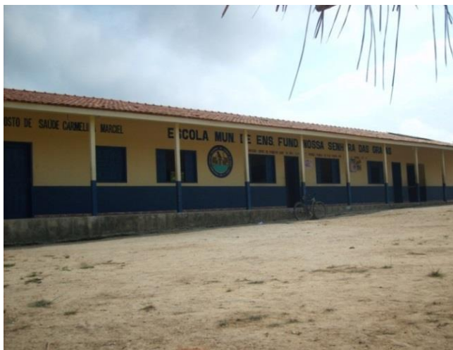
Figura 45 - Escola Nossa Senhora das Graças antes da obra de reforma com ampliação - Vitória do Xingu/PA.
