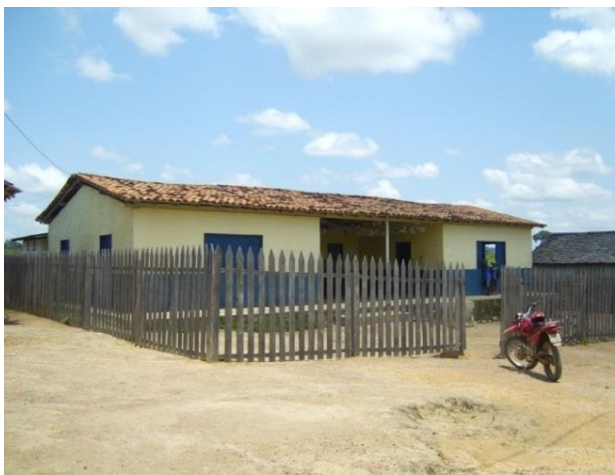
Figura 55 - Escola Rural Boa Esperança II antes da obra de reforma - Vitória do Xingu/PA.
