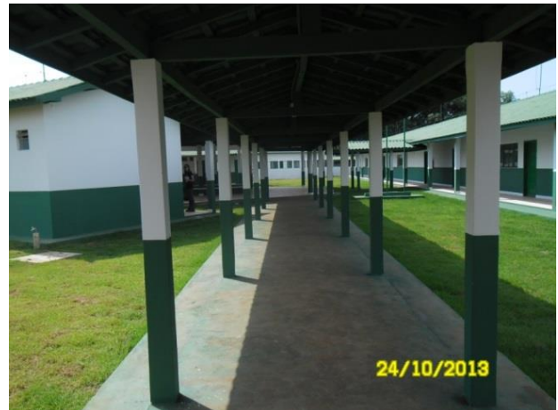
Figura 16 - Conclusão da obra de construção da EMEI Bela Vista Parque Ipê - Altamira/PA.
