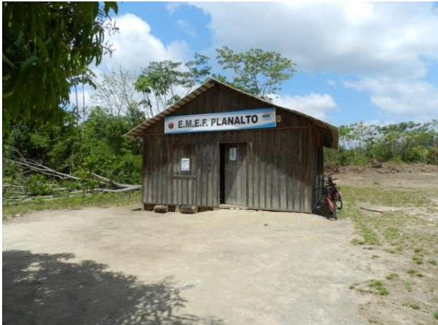
Figura 99 - EMEF Planalto antes da obra de construção - Senador José Porfírio/PA.
