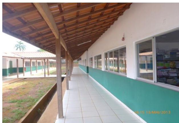
Figura 6 - Conclusão da obra de reforma com ampliação da EMEF Arthur Teixeira Jardim - Altamira/PA.
