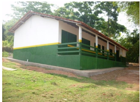
Figura 58 - Conclusão da obra de reforma com ampliação da Escola Gerosina - Vitória do Xingu/PA.
