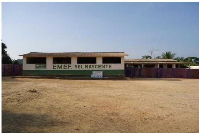
Figura 29 - EMEF Sol Nascente antes da obra de reforma com ampliação - Altamira/PA.
