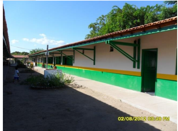
Figura 38 - Conclusão da obra de reforma com ampliação da EMEF Dulcinéia de Almeida do Nascimento - Vitória do Xingu/PA.
