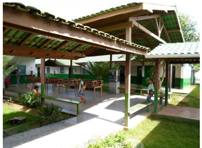
Figura 12 - Conclusão da obra de reforma com ampliação da EMEF Prof. Rilza Maria de Moura Acácio - Altamira/PA.
