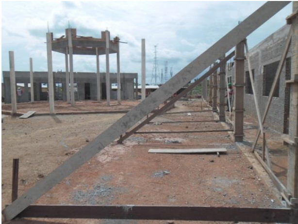
Figura 75 – Início da obra de construção da EMEF Dr. Acy de Jesus B. Pereira - Anapu/PA.
