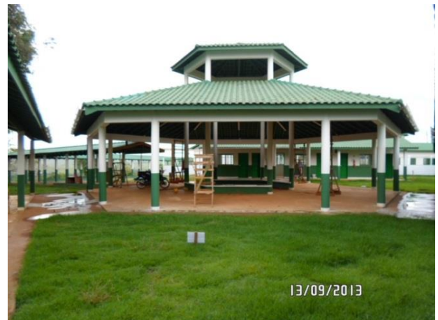
Figura 18 - Conclusão da obra de construção da EMEF Bela Vista Parque Ipê - Altamira/PA.
