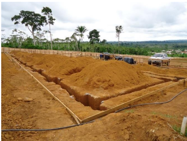
Figura 23 - Início da obra de construção da EMEF Jardim França - Altamira/PA.
