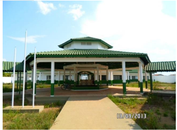
Figura 20 - Conclusão da obra de construção da EMEI Nova Altamira - Altamira/PA.
