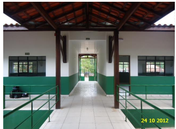
Figura 30 - Conclusão da obra de reforma com ampliação da EMEF Sol Nascente - Altamira/PA.
