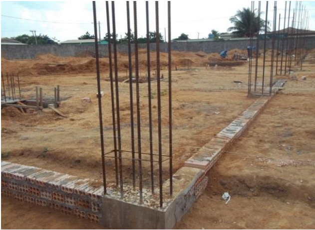
Figura 81 - Início da obra de construção da Quadra Poliesportiva da EMEF Irmã Terezinha Back - Brasil Novo/PA.
