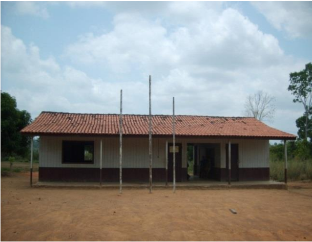
Figura 65 - Escola São Raimundo Nonato antes da obra de reforma com ampliação - Vitória do Xingu/PA.
