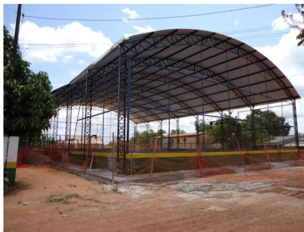
Figura 41 - Construção da Quadra da Escola Evangelho - Vitória do Xingu/PA.
