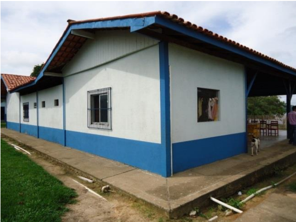
Figura 93 - EMEF Francisco Merêncio antes da obra de reforma com ampliação - Senador José Porfírio/PA.
