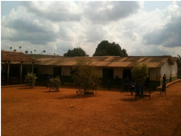
Figura 9 - EMEF Nossa Senhora Aparecida antes da obra de reforma com ampliação - Altamira/PA.
