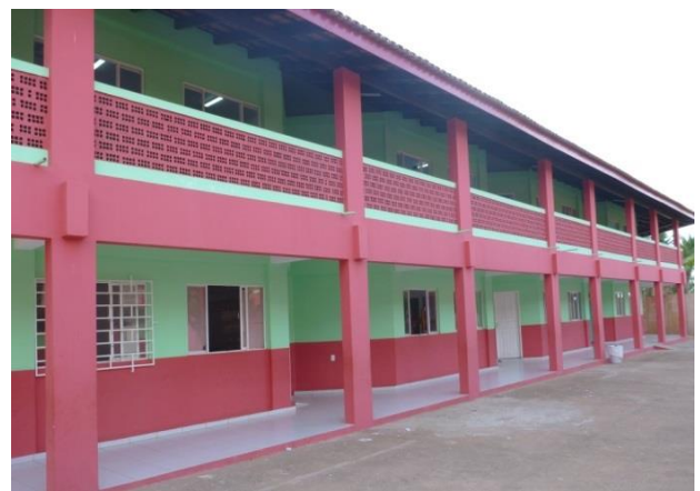
Figura 80 - Conclusão da obra de reforma com ampliação da EMEF Escola Irmã Terezinha Back - Brasil Novo/PA.
