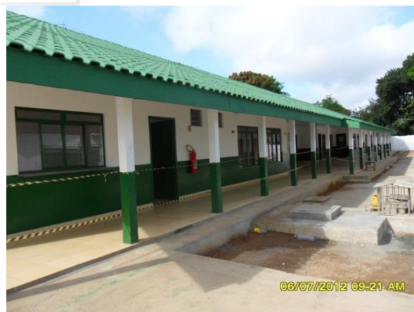
Figura 32 - Conclusão da obra de reforma com ampliação da Creche Municipal Ruth Passarinho - Altamira/PA.
