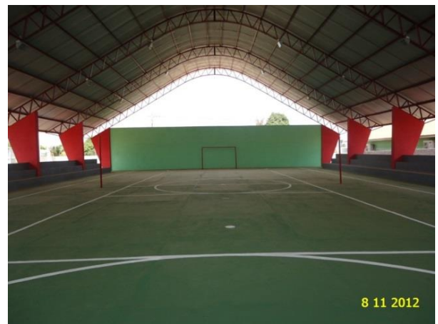
Figura 86 - Conclusão da obras de construção da Quadra Poliesportiva da EMEF Paraíso - Brasil Novo/PA.
