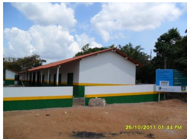
Figura 52 - Conclusão da obra de reforma com ampliação da Escola Nossa Senhora Aparecida III - Vitória do Xingu/PA.
