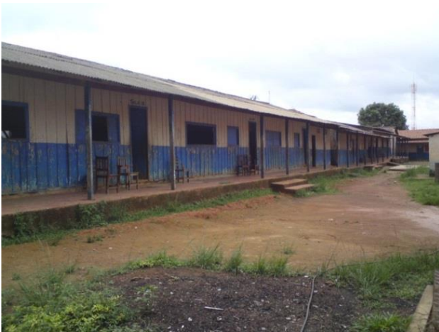
Figura 73 - EMEF Maria das Dores antes da obra de reforma com ampliação - Anapu/PA.
