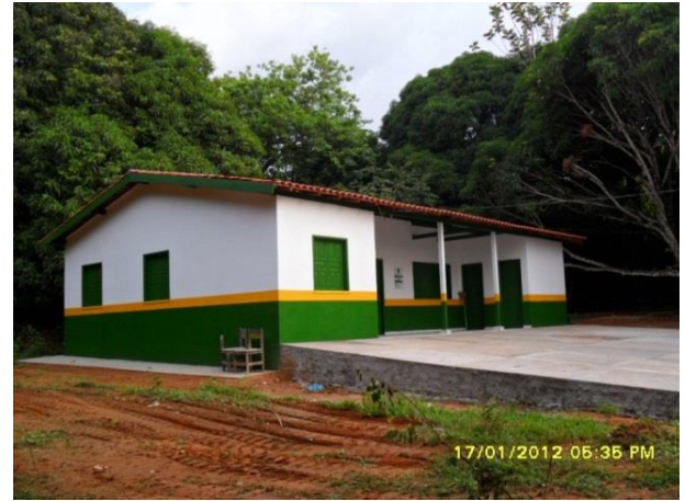
Figura 62 - Conclusão da obra de reforma com ampliação da Escola Napoleão Bonaparte - Vitória do Xingu/PA.
