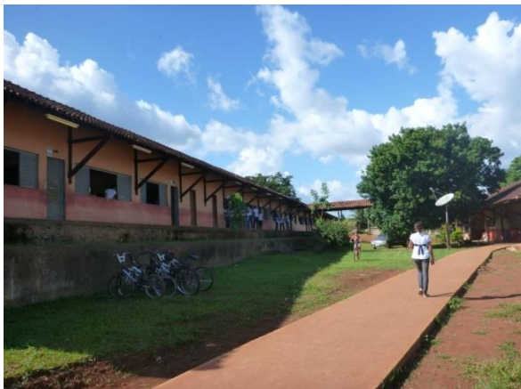
Figura 1 - EMEF Arthur Teixeira antes da obra de reforma com ampliação - Altamira/PA.
