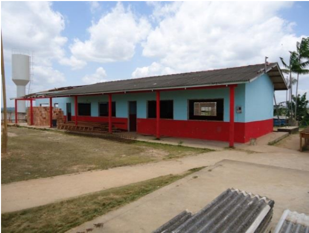
Figura 89 - EMEF Padre Léo Schneider antes da obra de reforma com ampliação - Brasil Novo/PA.
