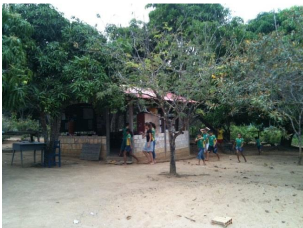
Figura 51 - Escola Nossa Senhora Aparecida III antes da obra de reforma com ampliação - Vitória do Xingu/PA.
