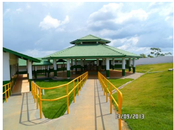
Figura 22 - Conclusão da obra de construção da EMEI Mutirão - Altamira/PA.
