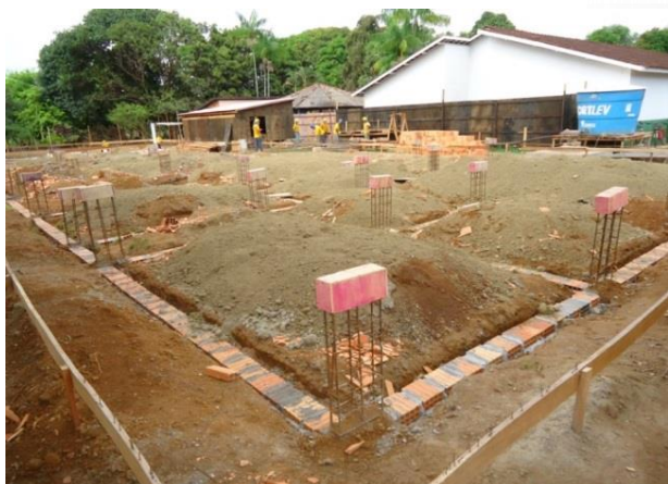
Figura 31 - Início da obra de reforma com ampliação da Creche Municipal Ruth Passarinho - Altamira/PA.
