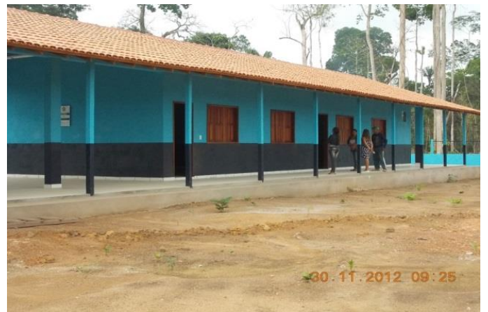
Figura 102 - Conclusão da obra de construção da EMEF PA Ressaca - Senador José Porfírio/PA.
