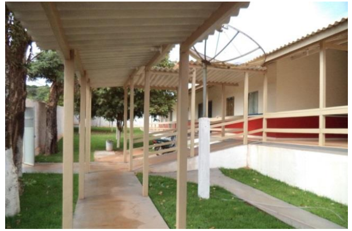
Figura 10 - Conclusão da obra de reforma com ampliação da EMEF Nossa Senhora Aparecida - Altamira/PA.
