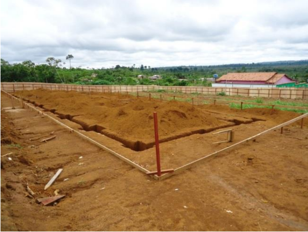
Figura 25 – Início da obra de construção da EMEI Jardim França - Altamira/PA.
