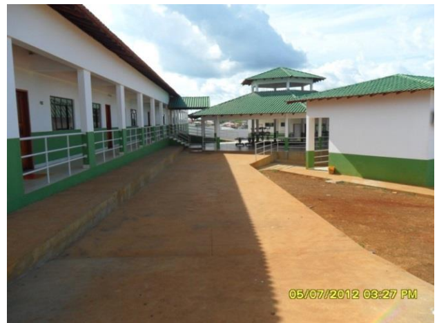
Figura 24 - Conclusão da obra de construção da EMEF Jardim França - Altamira/PA.
