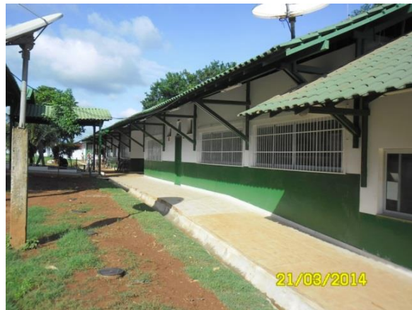
Figura 2 - Conclusão da obra de reforma com ampliação da EMEF Arthur Teixeira - Altamira/PA.
