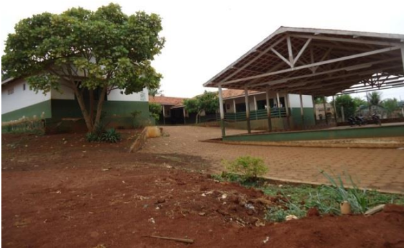
Figura 3 - EMEF Geraldo Emídio Bezerra antes da obra de reforma com ampliação - Altamira.
