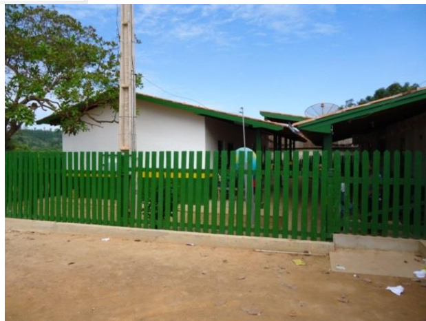
Figura 48 - Conclusão da obra de reforma com ampliação da Escola Santa Helena - Vitória do Xingu/PA.
