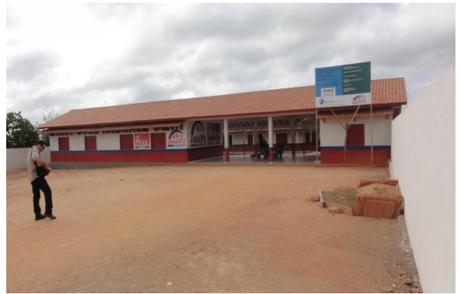
Figura 72 - Conclusão da obra de reforma com ampliação da Escola José Andrade Silva - Anapu/PA.
