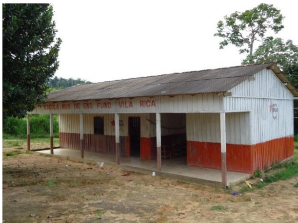
Figura 49 - Escola Vila Rica antes da obra de construção - Vitória do Xingu/PA.
