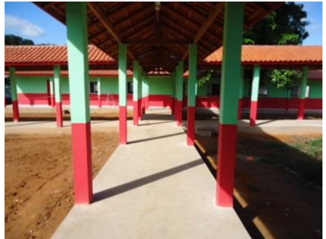
Figura 78 - Conclusão da obra de reforma com ampliação EMEF Brasil Novo - Brasil Novo/PA.
