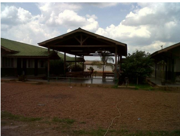
Figura 11 - EMEF Prof. Rilza Maria de Moura Acácio antes da obra de reforma com ampliação - Altamira/PA.
