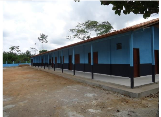
Figura 100 - Conclusão da obra de construção da EMEF Planalto - Senador José Porfírio/PA.
