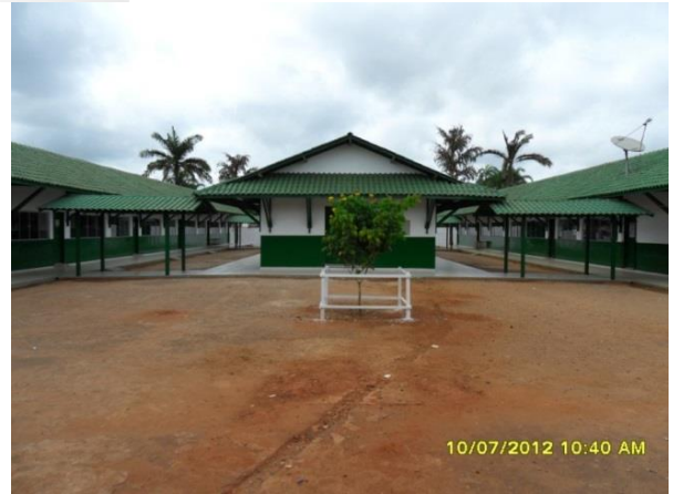
Figura 8 - Conclusão da obra de reforma com ampliação da EMEF José Edson Burlamaqui de Miranda - Altamira/PA.
