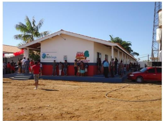
Figura 74 - Conclusão da obra de reforma com ampliação da EMEF Maria das Dores - Anapu/PA.
