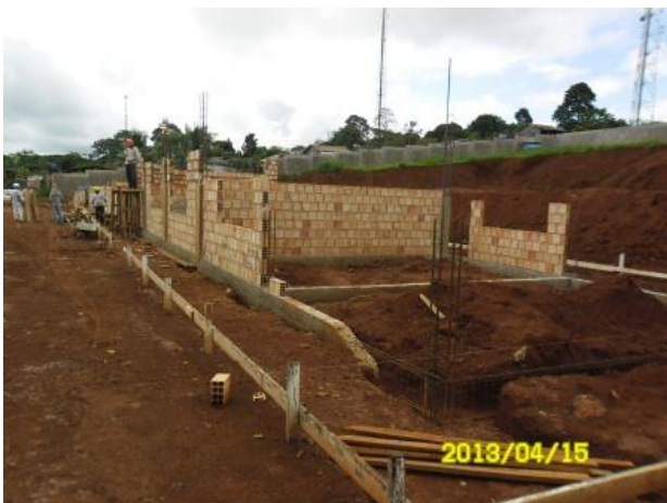
Figura 33 - Início da obra de construção da EMEF Anísio de Araújo Uchôa - Altamira/PA.
