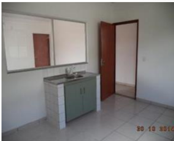
Figura 4.6.2 - 44 – Berçário com revestimento interno finalizado e pia inox assentada.
