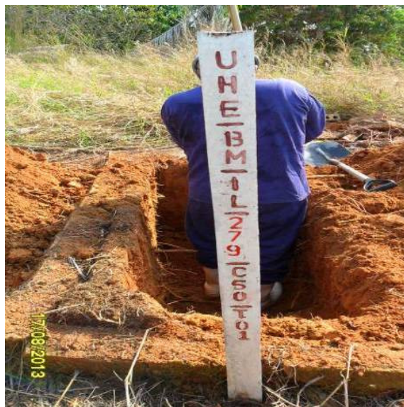
Figura 4.3.3 - 63 – Trabalho realizado no C50 durante as escavações.
