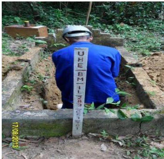
Figura 4.3.3 - 65 – Trabalho realizado no C51 durante as escavações.
