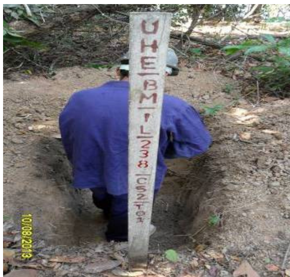
Figura 4.3.3 - 67 – Trabalho realizado no C52 durante as escavações.
