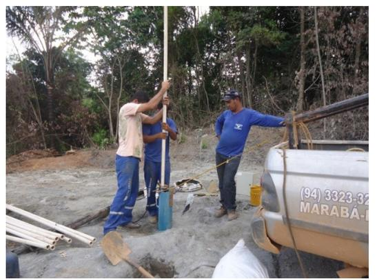
**Figura 4 – Construção do poço para captação de água – Garimpo do Galo.**
