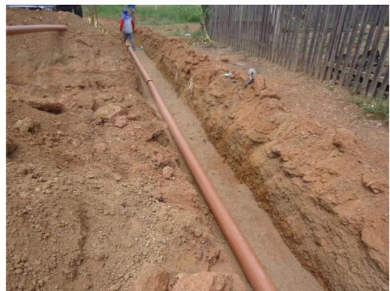
**Figura 6 – Assentamento de tubulação para instalação da rede coletora d esgoto – Ressaca.**
