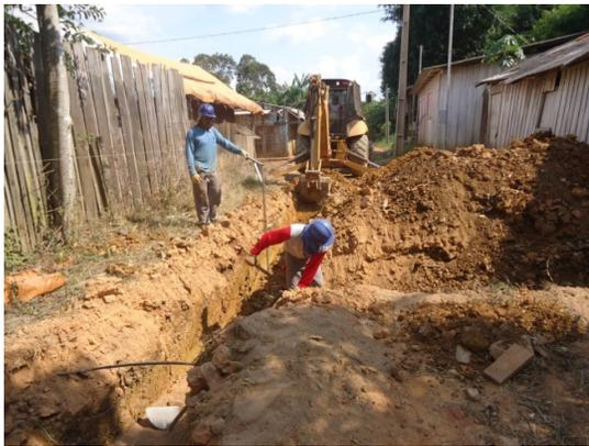
**Figura 3 – Abertura de vala para passa tubulação de coleta do esgoto – Garimpo do Galo.**
