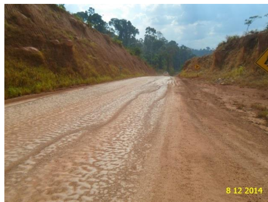
Figura 8 – O travessão está com boa trafegabilidade, neste trecho pode ser visto corte em solo, com boa estabilidade de talude.
