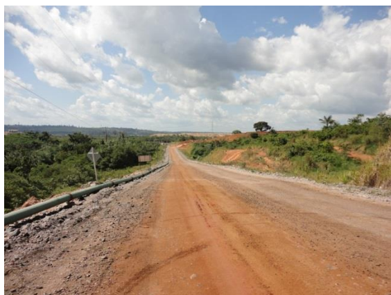
Figura 11 – Via nova utilizada para as obras próximas à Barragem Principal.
