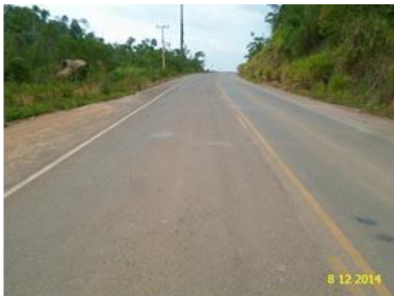
Figura 1 – Travessão que liga BR 230 a fazendas e canais da UHE, está com pavimento asfáltico, sinalização, proteção lateral com guard rail e na maioria do trecho apresenta boas condições de trafegabilidade.
