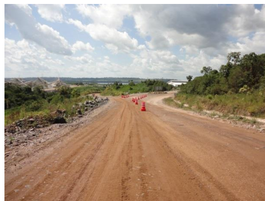
Figura 12 – Pista com pavimentação em solo e cobertura em cascalho, com sinalização de obra (temporária) e vertical. Boas condições de trafegabilidade em toda sua extensão.
