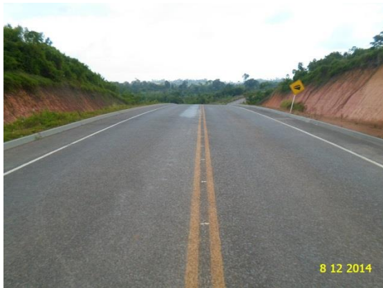
Figura 13 – Sinalização, pavimentação asfáltica, em bom estado de conservação.
